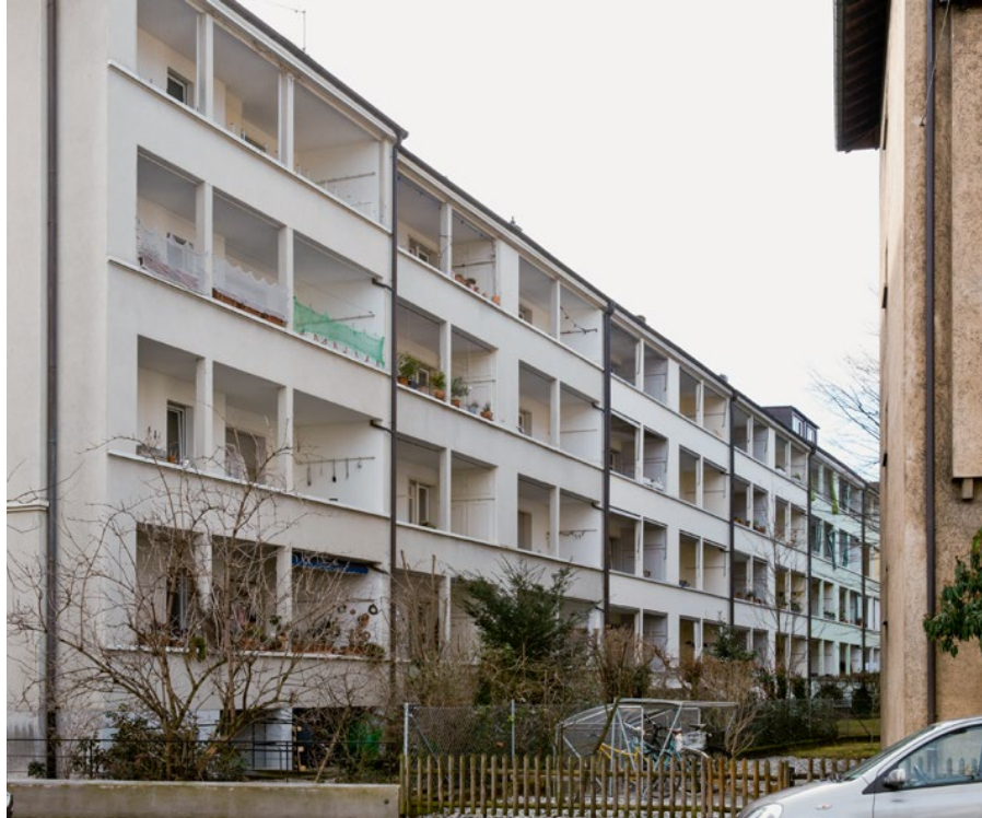
Baumgartnerhäuser, Dachsfelderstrasse, Baumgartner Hindermann, 1930
