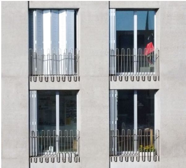
Haus an der Feldbergstrasse 47, Stump & Schibli, 2018
