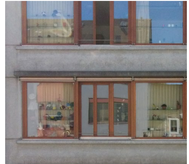
Wohnhaus an der Birmannsgasse 37, Michael Alder, 1997
