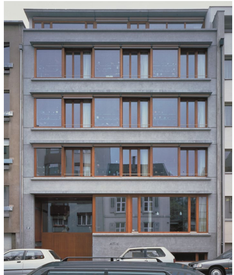
Wohnhaus an der Birnmanngasse 37, Michael Alder, 1997
