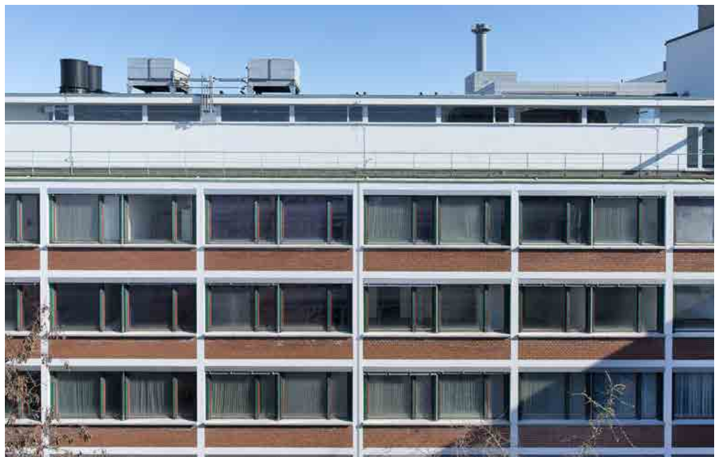
Ansicht West / Innenhof, Detail Fassade
