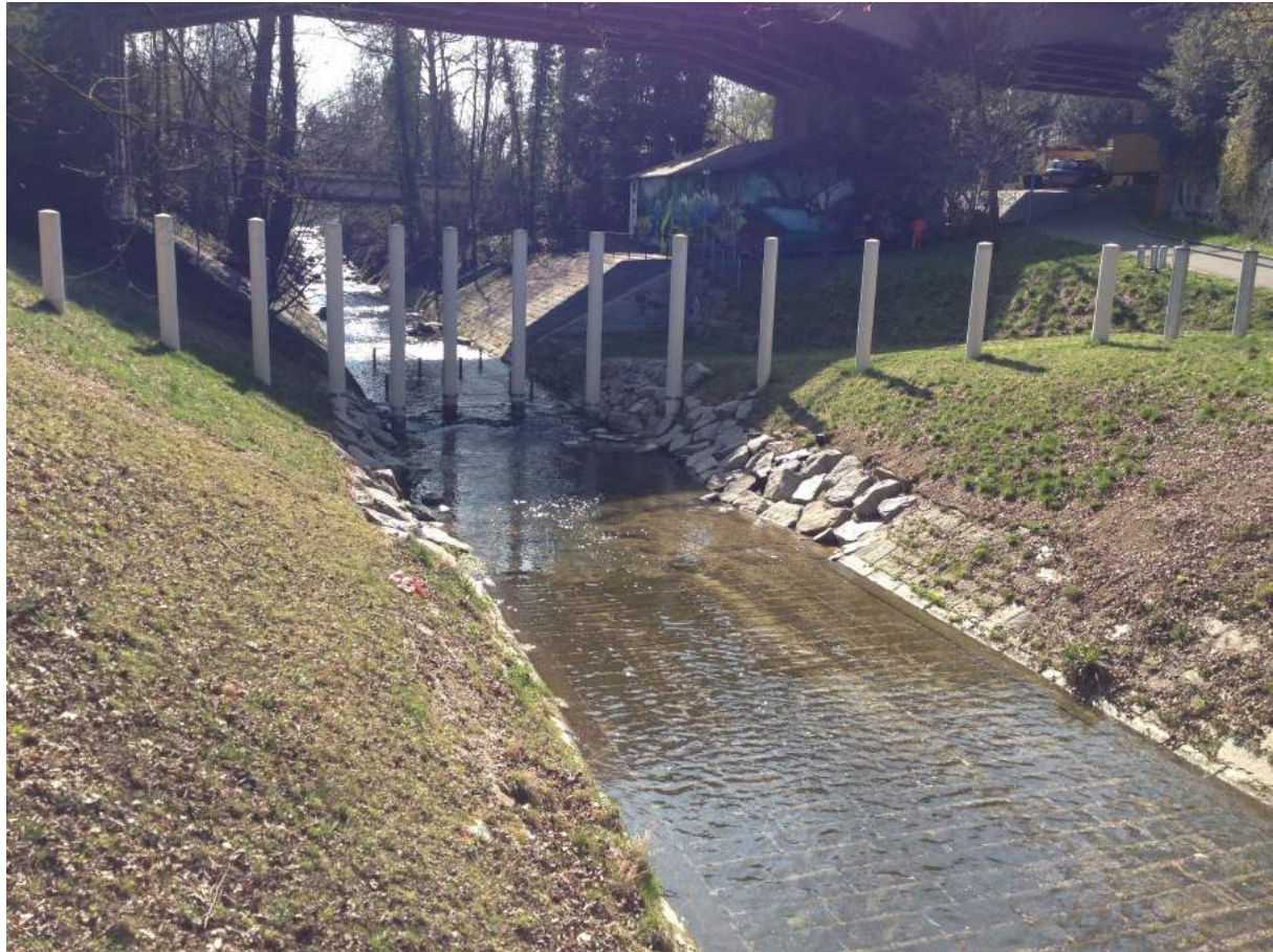
Fig. 7: Birsig unterhalb des Dorenbachviadukts (BG2). Die Säulen im Querprofil sollen Verklausungen im weiter unten liegenden Bereich der Eindolung verhindern.
