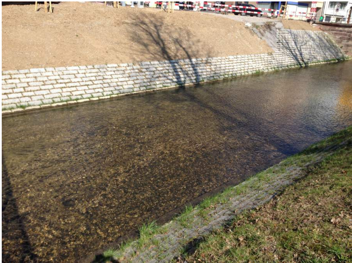
Fig. 6: Der Birsig kurz vor seiner Eindolung im Innenstadtbereich (BG1) fliesst in einem Trapezprofil.
