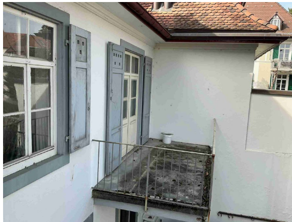
Haus Nr. 26 - Balkon OG
