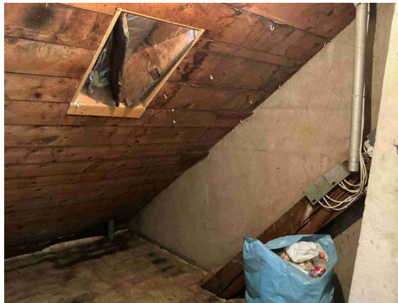
Haus Nr. 26 - Estrich DG
