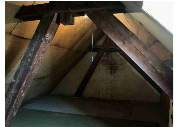
Haus Nr. 26 - Estrich
