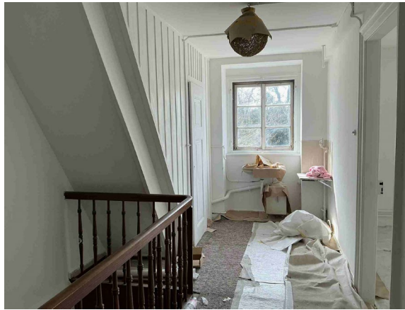
Haus Nr. 26 - Gang DG
