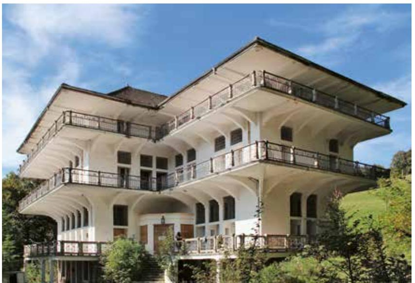
Tragende Werte realisierte der Ingenieur François Hennebique 1912/13 mit der Eisenbetonkonstruktion des Manoir Hauteroche in Le Pont (VD), hoch über dem Lac de Joux. Das monolithische Tragwerk mit seinen freien Formen ist tragsicher wie eh und je und bestimmt bis heute das Erscheinungsbild des Herrenhauses. Für die Beurteilung und Erhaltung historischer Tragwerke steht mit der Normenreihe SIA 269 ein wichtiges und speziell auf Bestandsbauten ausgerichtetes Instrument zur Verfügung.
