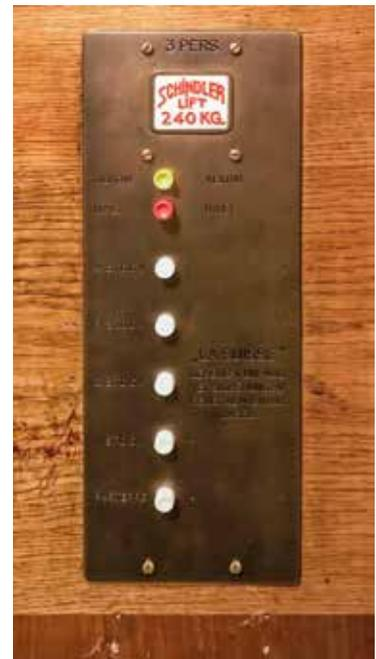
Die originale Schalttafel wurde restauriert und mit der neuen Steuerung ausgerüstet.
