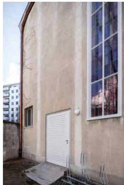
Der Umbau der First Church of Christ, Scientist in Basel mit ihrer charakteristischen Schauseite erforderte auch eine Erdbebenertüchtigung. Dabei wurde eine ebenso diskrete wie effektive Lösung gefunden: In den seitlichen Aussenwänden wurden vorgespannte Stahlstangen zur Stabilisierung eingebaut. An der Aussenhaut ist nur eine Verputzreparatur sichtbar.
