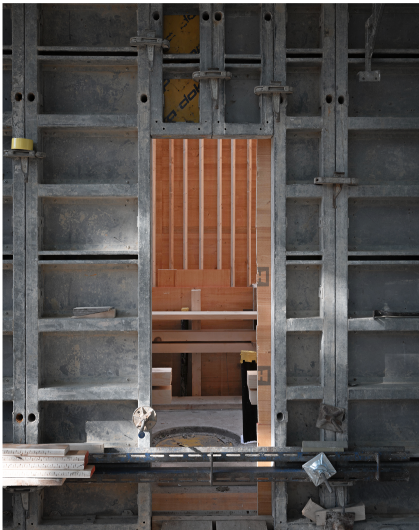
Schalung für das Einbringen von Trasskalk
