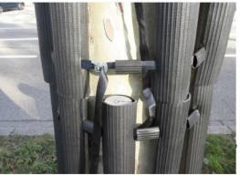
h) Nun zuerst den unteren, danach den mittleren und zum Schluss den oberen Spannriemen anziehen.
