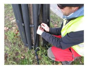
e) Die Tubes sollen möglichst gleichmässig und mit geringem Abstand um den Baumstamm verteilt sein.
