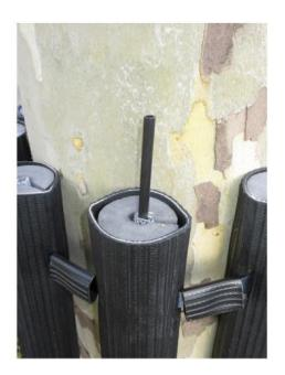
g) Anschliessend die obere Lage Stammschutzelemente aufstecken. (Bei Stammformen, deren Durchmesser nach oben hin stark abnehmen, werden in der oberen Lage eventuell weniger Tubes benötigt. Es kann in diesem Fall freigelassen werden.)
