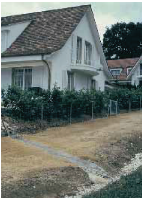
Die offene Rinne leitet das Dachwasser in den Entwässerungsgraben.
