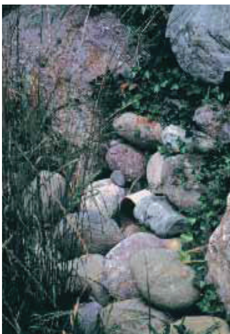
Einlauf des Dachwassers in die Versickerungsmulde
