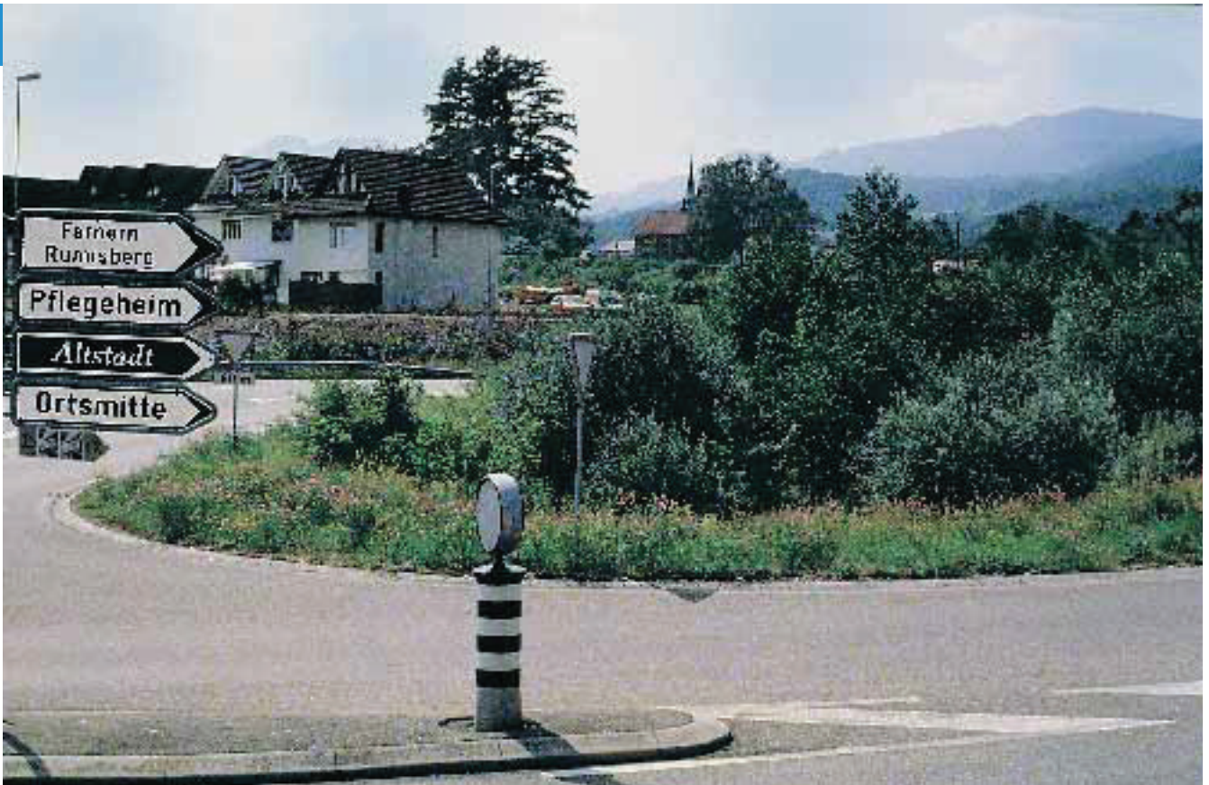
Retentions- und Versickerungsbecken mitten im Strassenkreisel
