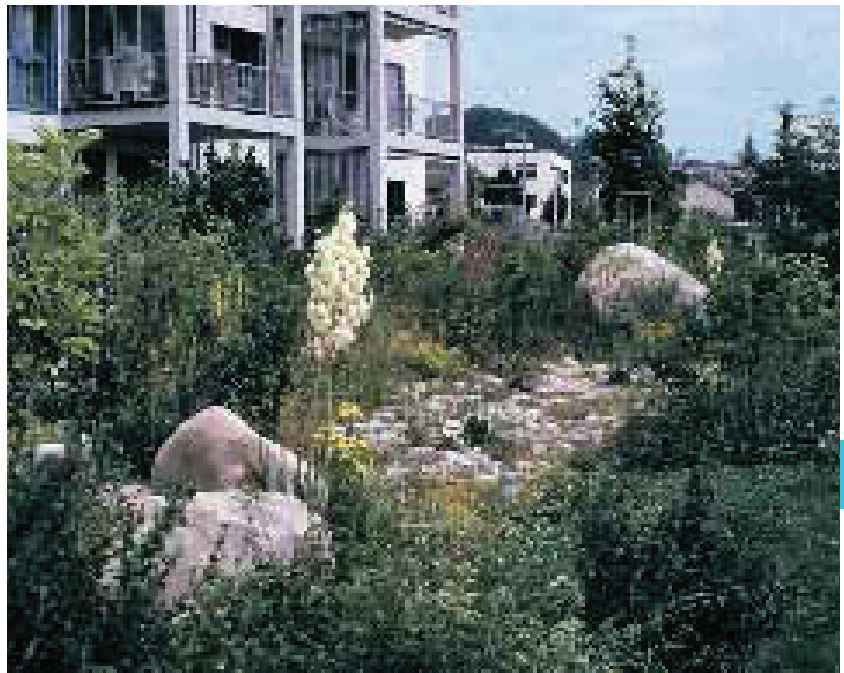
Blick auf die Versickerungsmulde
