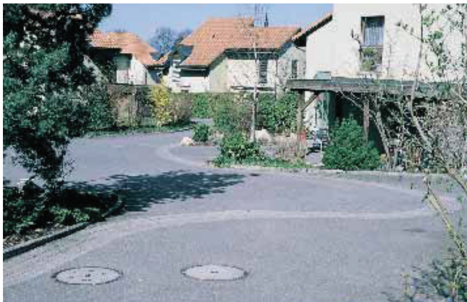
Abflussrinnen als Gestaltungselement im Strassenbereich
