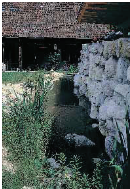
Das Dachwasser des Autounterstandes tropft direkt in das kleine Biotop
