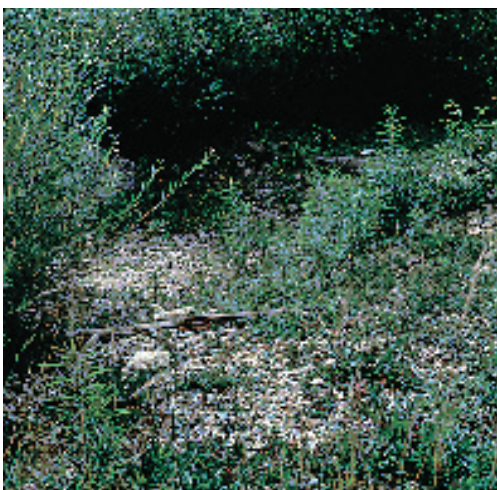
Offenes Gerinne für die Ableitung des Regenwassers
