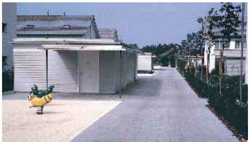
Interne Verbindungswege aus porösen Pflastersteinen
