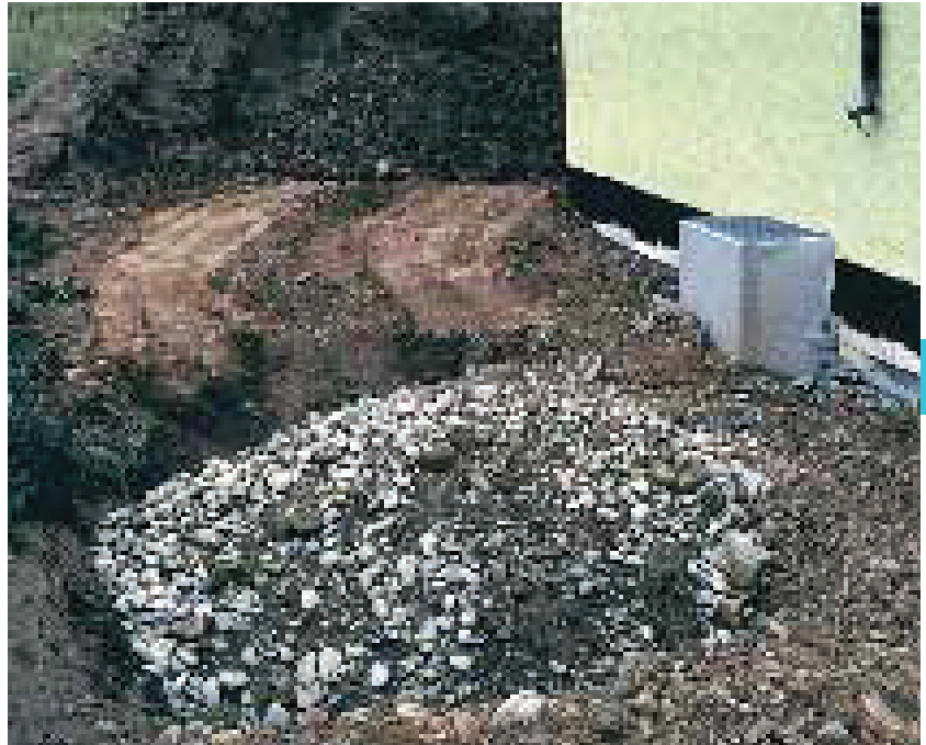
Entstehung einer Versickerungsmulde: Eben wurde das Wandkies eingeschüttet
