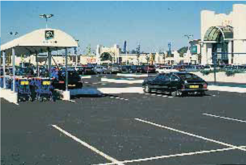
Einkaufszentrum: unter dem grossen Parkplatz befindet sich ein Unterstrassenspeicher
