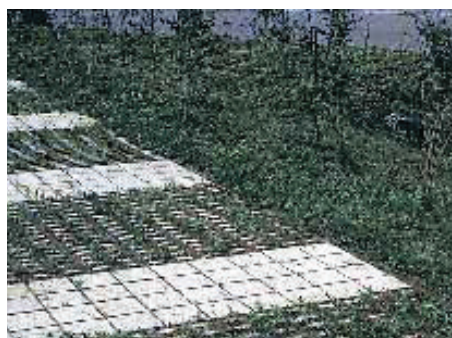
Interne Verbindungswege aus porösen Pflastersteinen
