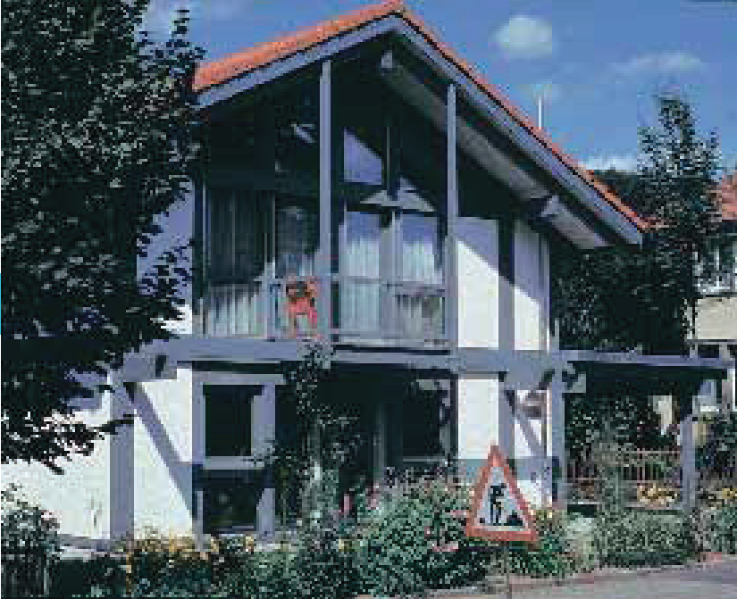
Zufahrt und Umgebungswege sind mit Kies bedeckt. Das Regenwasser kann direkt versickern
