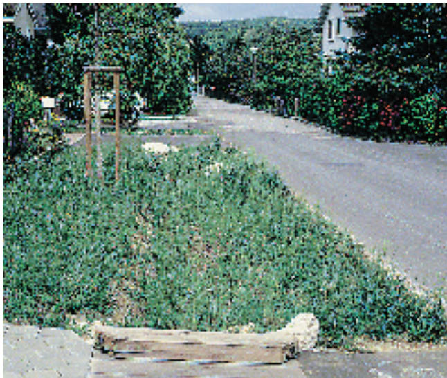
Seitlicher Versickerungsgraben
