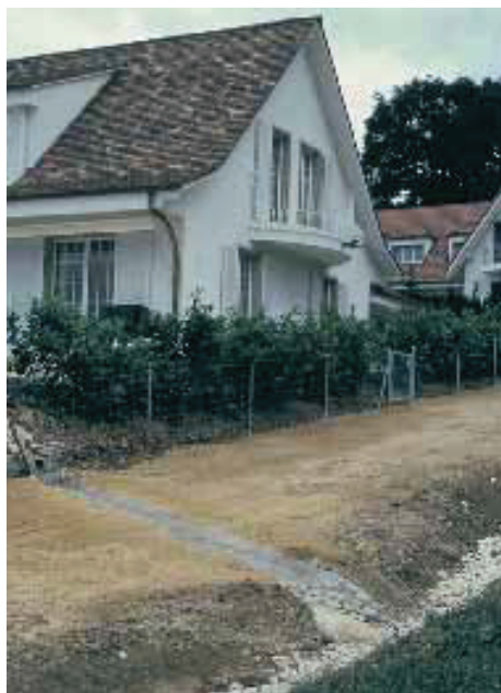
Die offene Rinne leitet das Dachwasser in den Entwässerungsgraben.
