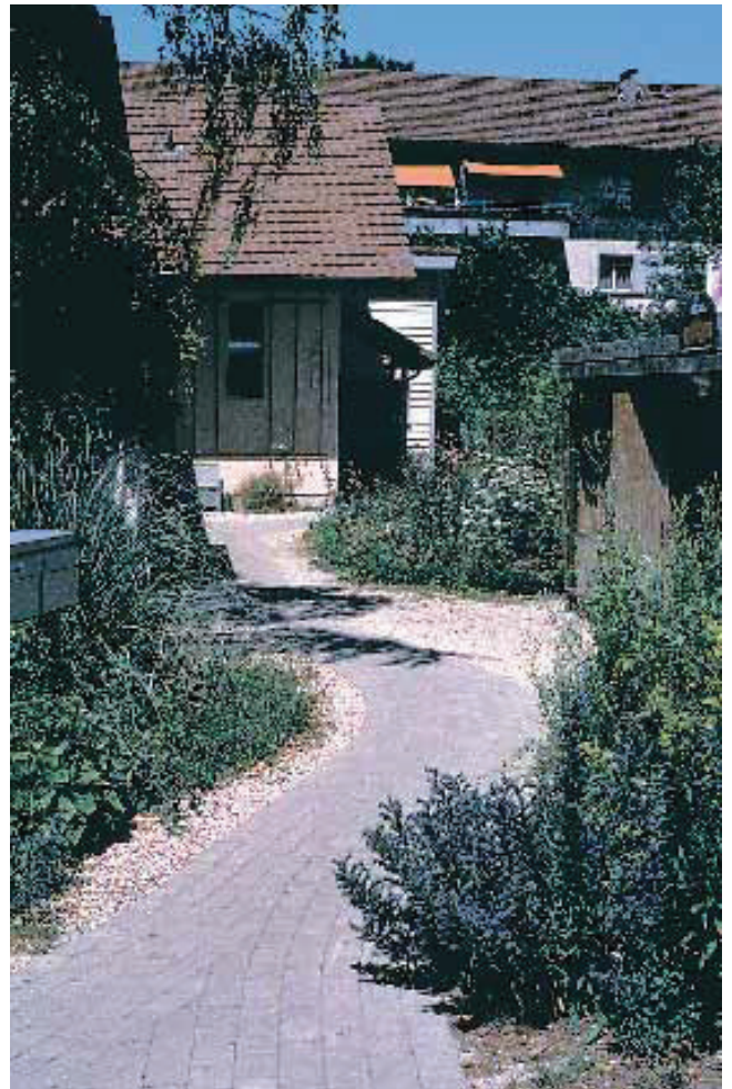
Pflastersteine mit seitlichen Kiesstreifen
