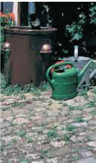
Regenfass: Nutzung des Dachwassers als Gartenwasser
