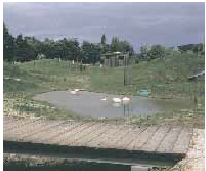
Retentionsbecken im Bereich des Robinsonspielplatzes
