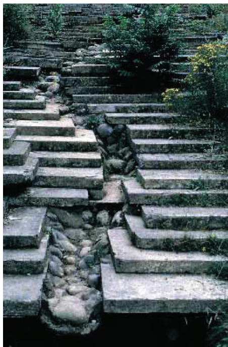
Fortsetzung des Gerinnes: Wiederverwendete, alte Balkonbrüstungen gestalten die Geländestufe
