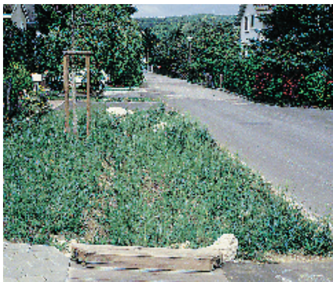
Seitlicher Versickerungsgraben
