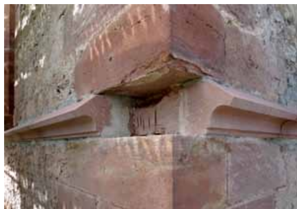
Weite Teile des gekehlten Gurtgesimses am Turm waren in schlechtem Zustand und wurden ersetzt. Die Steinmetze der Basler Münsterbauhütte (rechts) leisteten dabei sorgfältige Arbeit.
