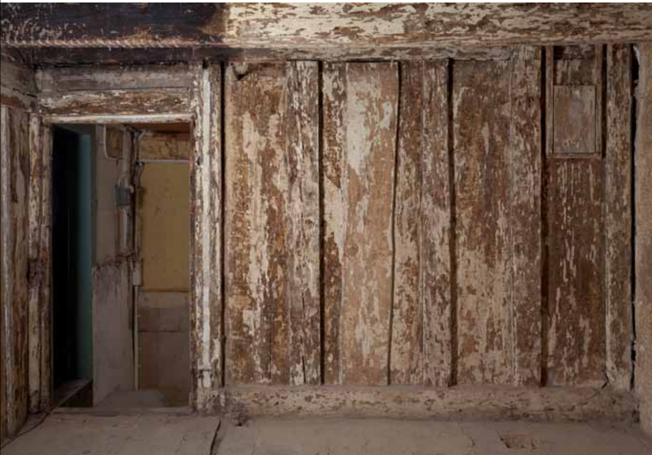
Imbergässlein 3. Einen seltenen Befund stellt die Ständerwand im 3. Obergeschoss dar: Sie stammt aus der Bauzeit um 1358. Zwischen die genuteten Ständer sind kräftige Wandbohlen eingeschoben. Rechts oben ist eine kleine Lüftungsöffnung mit Schiebeladen zu sehen.
