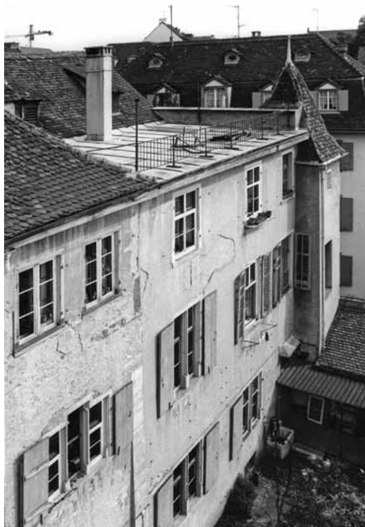
Blick von der Dachterrasse des Hauses Zum Samson (Nr. 18) auf die Rückseite des Oberen Samson mit Abortturm. Foto 1982.
