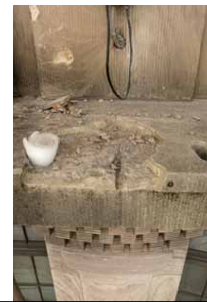
Details der Globus-Fassade vor der Restaurierung (im Uhrzeigersinn): Figürliches Relief am Eckerker; schadhafte Stelle mit korrodierter Armierung am Dachhimmel; beschädigte Kunststeinelemente am Balkon gegen die Eisengasse; mit Platten aus Castione-Stein verkleideter Erker gegen die Eisengasse; schadhafte Balkonplatte aus Kunststein; Dachhimmel gegen die Eisengasse.
