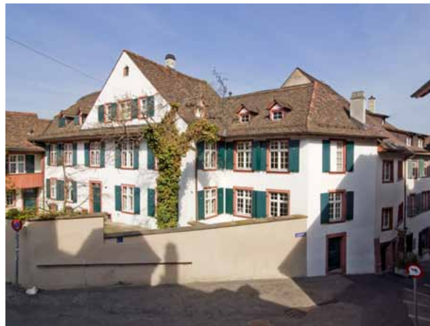
Frey-Grynaeisches Institut, Heuberg 33. Eine Hofmauer verbirgt die Gebäude an der Ecke zum Leonhardsberg.
