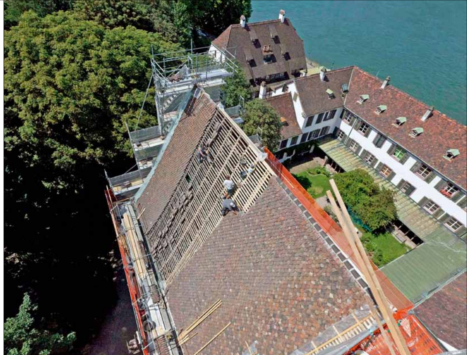
Blick vom Turmgerüst der St. Alban-Kirche auf die Dachdecker bei der Neueindeckung des Kirchenschiffs. Foto September 2012.
