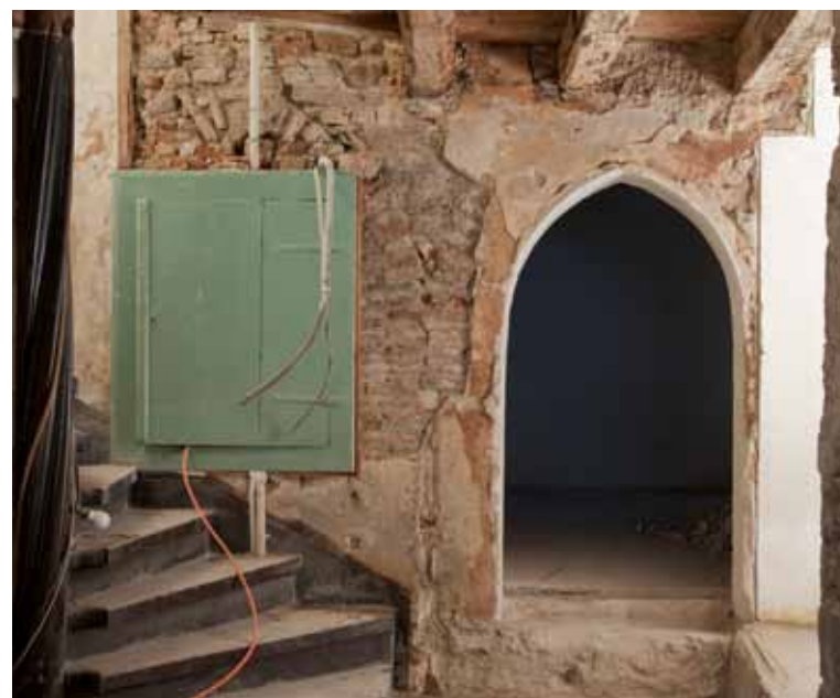
Imbergässlein 3. Zwei Spitzbogentüren in der Binnenmauer des Hauses aus der Bauzeit um 1358. Die Türbogen sind vollständig aus Backsteinen gemauert. Während die Tür rechts noch heute besteht und vom Treppenflur in das Zimmer am Imbergässlein führt, ist die linke Öffnung teilweise vermauert und dient heute als Schranknische. Der hinter dieser Tür einst ausgeschiedene, fensterlose Raum war zeitweise eine Verbindung zwischen den benachbarten Bauten Schneidergasse 24 und Imbergässlein 5. Noch um 1868 überliefert ein Grundbucheintrag die Zugehörigkeit des 1. Obergeschosses von Imbergässlein 3 zur Liegenschaft Schneidergasse 24.
