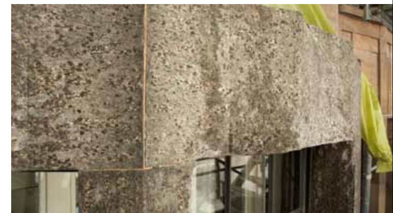
Details der Globus-Fassade vor der Restaurierung (im Uhrzeigersinn): Figürliches Relief am Eckerker; schadhafte Stelle mit korrodierter Armierung am Dachhimmel; beschädigte Kunststeinelemente am Balkon gegen die Eisengasse; mit Platten aus Castione-Stein verkleideter Erker gegen die Eisengasse; schadhafte Balkonplatte aus Kunststein; Dachhimmel gegen die Eisengasse.
