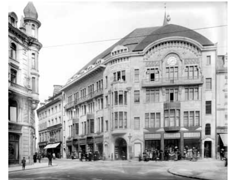
Das 1904/05 von Romang & Bernoulli errichtete und 1909 entlang der Eisengasse durch Bernoulli, Wenk & Cie/Karl August Burckhardt erweiterte Warenhaus Globus, Marktplatz 2/Eisengasse 17. Foto nach 1909.
