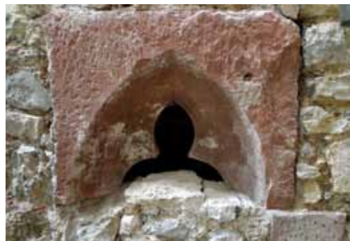
An der Südfassade kam bei der Entfernung des Verputzes von 1911 überraschend ein vermauertes Lanzettfenster aus dem 13. Jahrhundert zum Vorschein (siehe den Plan unten). Foto Juli 2012.
