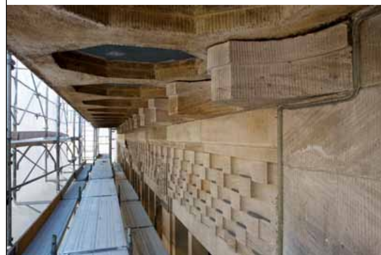
Details der Globus-Fassade vor der Restaurierung (im Uhrzeigersinn): Figürliches Relief am Eckerker; schadhafte Stelle mit korrodierter Armierung am Dachhimmel; beschädigte Kunststeinelemente am Balkon gegen die Eisengasse; mit Platten aus Castione-Stein verkleideter Erker gegen die Eisengasse; schadhafte Balkonplatte aus Kunststein; Dachhimmel gegen die Eisengasse.
