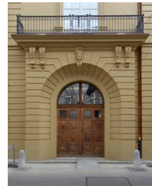
Der erstmals 1691 in Paris erschienene Cours d'Architecture von Charles Augustin D'Aviler lieferte die Vorlagen zur Architektur und Innendisposition des Markgräflerhofs. Wie der Vergleich des Mitteleingangs und eines Durchfahrtstors mit verschiedenen Portalen auf einem Musterblatt aus diesem Werk belegt, wurde auch die Gestaltung einzelner Bauglieder übernommen.
