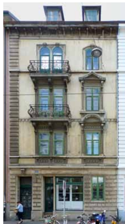
Das 1903 errichtete Wohnhaus mit Geschäftslokal an der Güterstrasse 122. Die Fotos vor und nach der Restaurierung der Fassade zeigen den Wandel vom angegrauten Altbau zum neuen Blickfang gegenüber dem Bahnhofsausgang.
