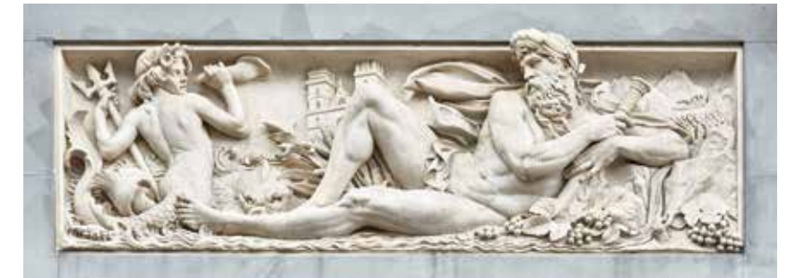
Marmorreliefs mit den Allegorien der Architektur und des Rheins von Charles Iguel an der Hauptfassade zum Steinenberg, 1880–1882.
