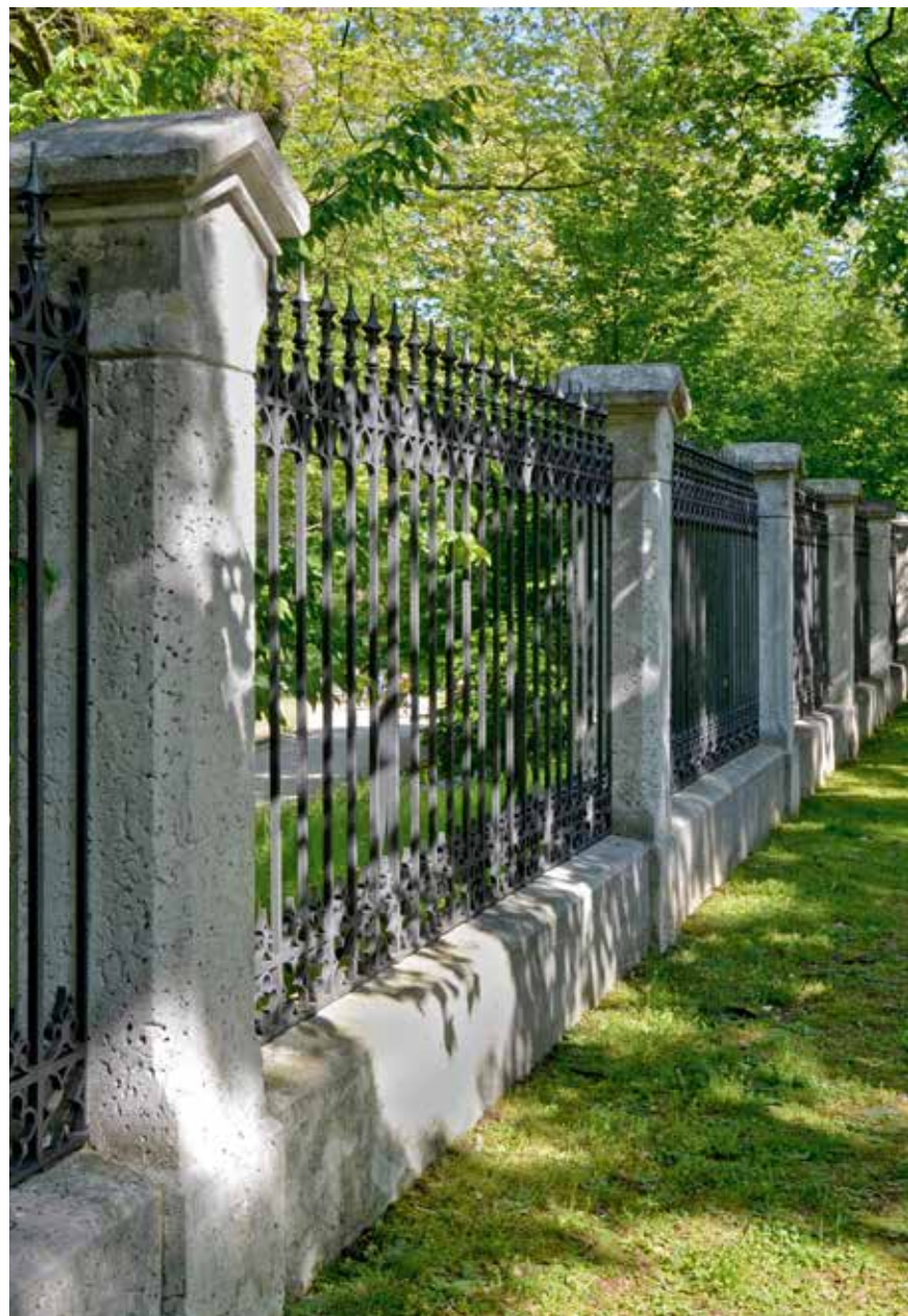
Die Einfriedung des Kannenfeldparks stammt aus der Bauzeit des Friedhofs 1867/68 und besteht aus einem gusseisernen, durch Zwischenpfosten unterteilten Staketenzaun über kniehohem Sockelmauer. Bei der Restaurierung wurde der Solothurner Kalkstein gereinigt und die Fehlstellen durch Aufmodellierungen ergänzt.
