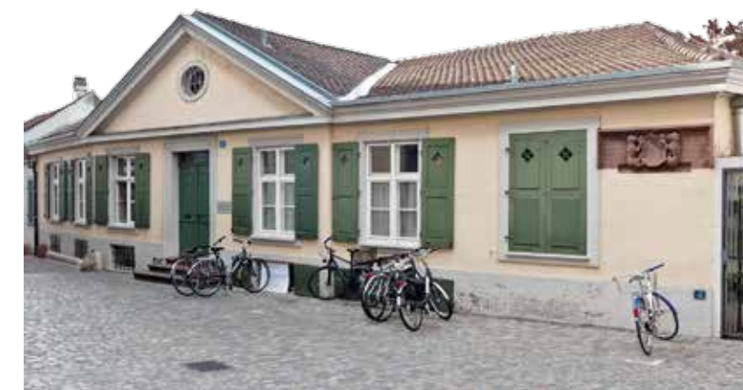
Haus Rheinsprung 21, ehem. Kornhaus. Fassade am Rheinsprung. Fenster, Dach und Dreiecksgiebel stammen von 1817. Foto vor dem Umbau.
