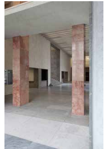
Nahtstelle zwischen dem umgestalteten und dem konservierten Bereich im Erdgeschoss des Altbaus: Blick vom ehemaligen Wechelausstellungssaal ins Foyer.
