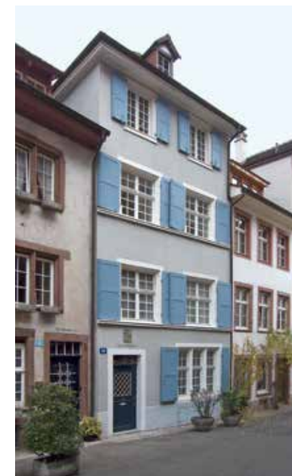
Haus Peterskirchplatz 13. In seiner heutigen Form geht das Gebäude auf das 15. Jahrhundert zurück. 1844 wurde es gegen die Strasse um ein Geschoss erhöht. Die Vorderseite zeigt eine moderne Farbgebung aus der zweiten Hälfte des 20. Jahrhunderts. Bei einem künftigen Fassadenanstrich wäre eine sich am historischen Befund orientierende Neufassung zu erwägen.
