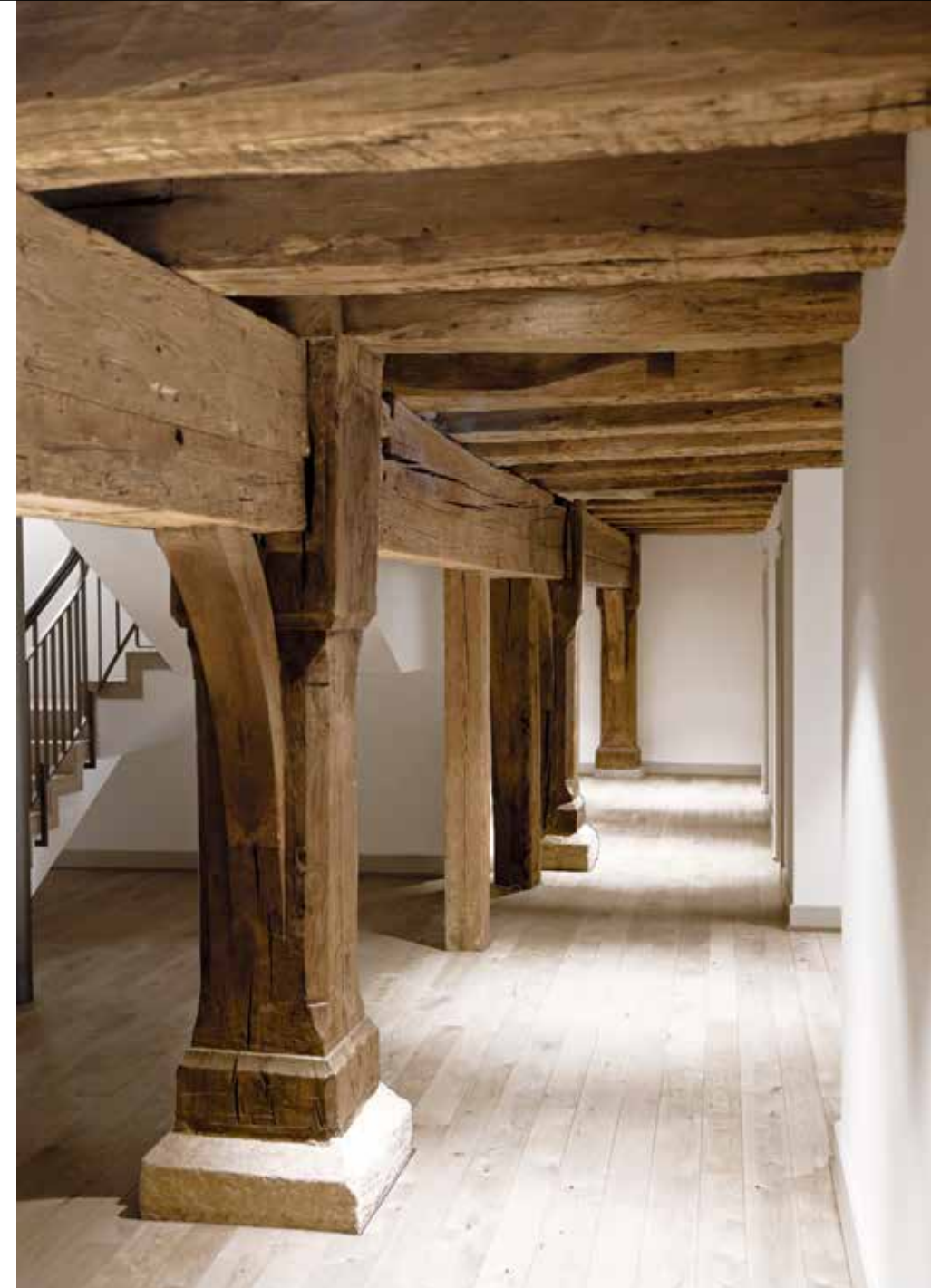
Das 2. Untergeschoss nach dem Umbau 2016. Die Stützen der Tragkonstruktion und die Deckenbalken prägen seither wieder frei und sichtbar den Raumeindruck
