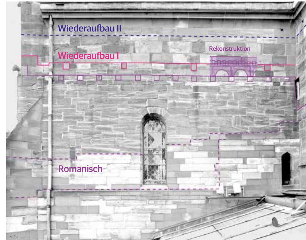
Westseite des nördlichen Querhauses mit Kennzeichnung der Bauphasen (durchgezogene Linie) und Bauetappen (gestrichelte Linie). Der ehemalige romanische Wandabschluss mit Blendbögen und Zahnfries ist als Rekonstruktion angedeutet.
