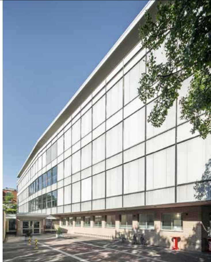
Das 1955–1957 beim Horburgpark errichtete Personalgebäude [Bau K-430] befindet sich samt der Vorhangfassade weitgehend im Originalzustand.
