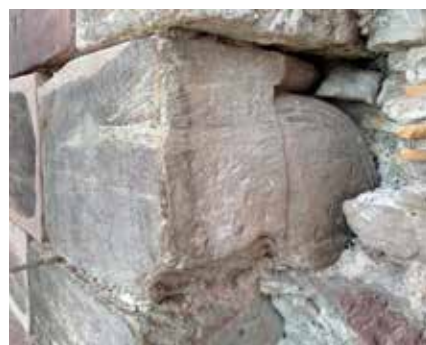
Romanische Wandvorlage, wiederverwendet als Baumaterial in dem kurz nach dem Erdbeben von 1356 wiederaufgebauten Giebelmauerwerk.
