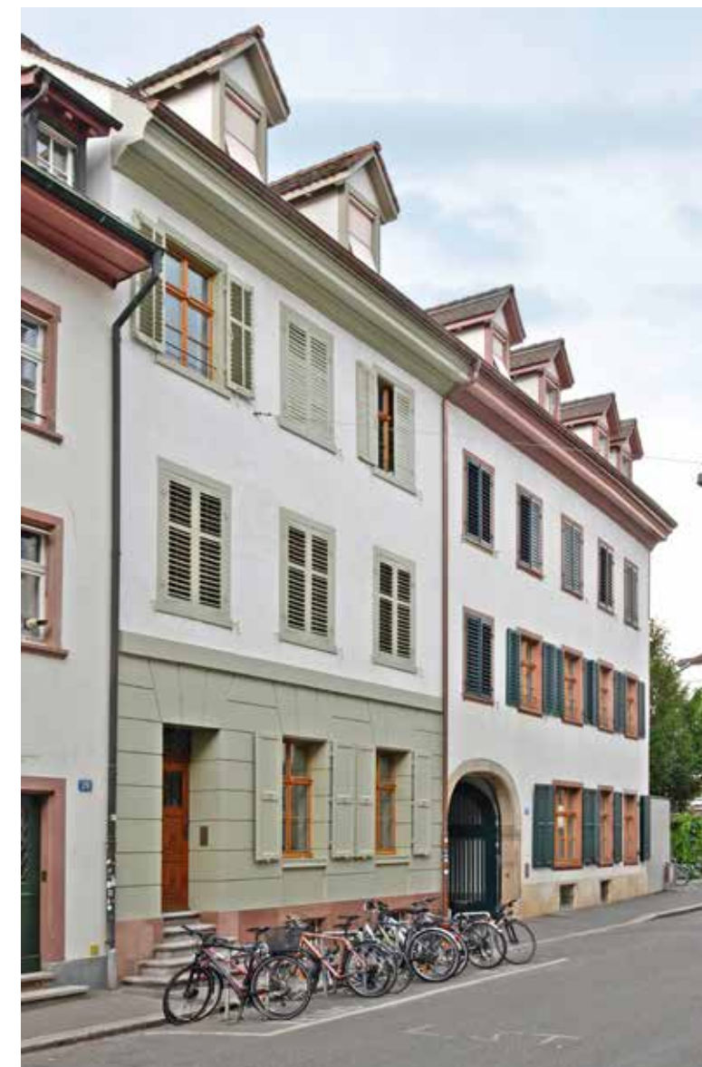
Der Gebäudekomplex der ehemaligen Lotz'schen Färberei gegen die Rheingasse nach Abschluss der Instandsetzungsarbeiten. Links das 1839 klassizistisch überformte Wohnhaus des Fabrikherrn (ehemaliger Unterlindenhof), rechts das 1855 aus zwei Häusern vereinigte Verwaltungsgebäude mit Durchfahrt von 1671.
