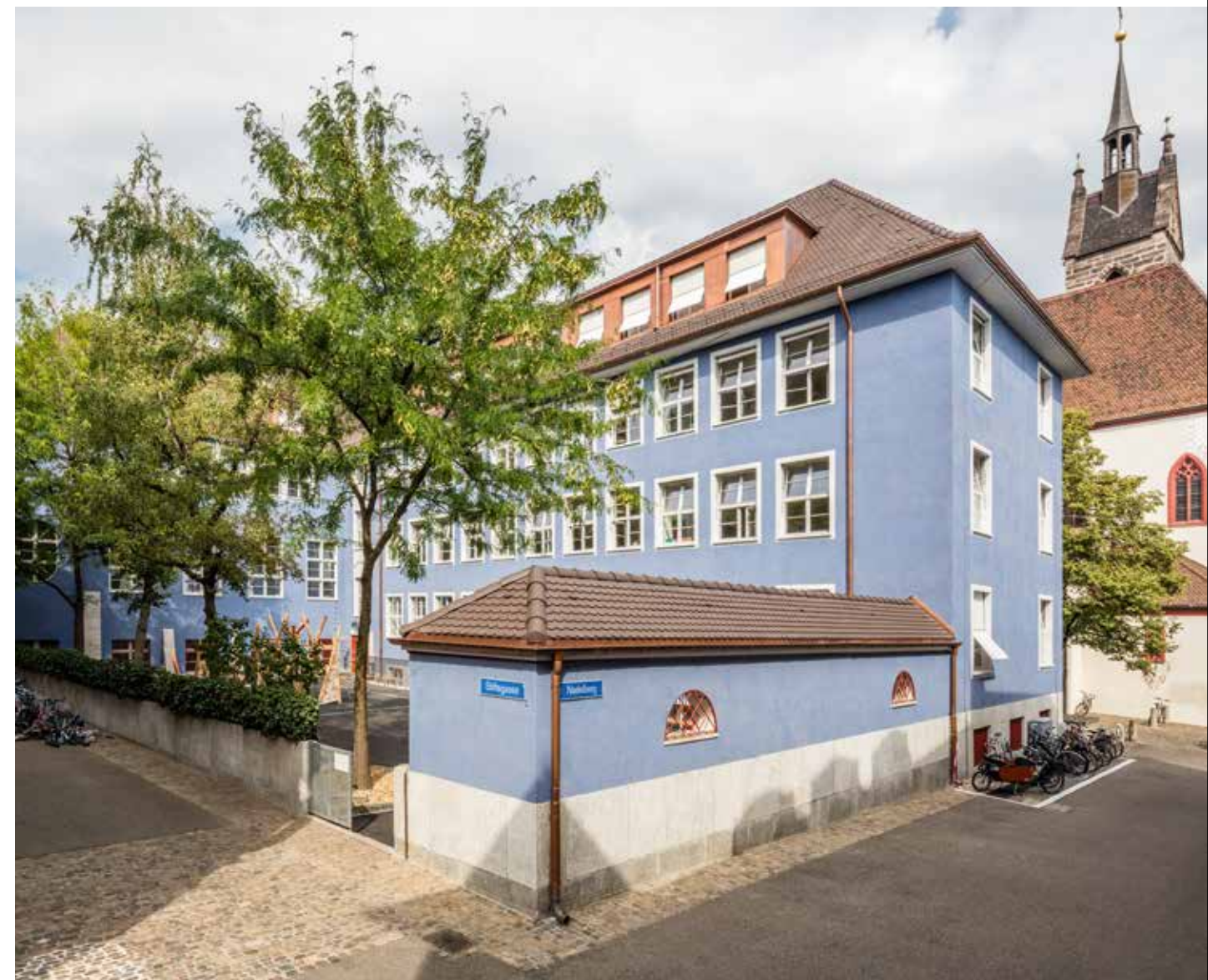
Ansicht des sanierten Petersschulhauses vom Nadelberg mit umfriedetem Schulhof und eingeschossiger, gegen die Allmend hin geschlossener Pausenhalle.
