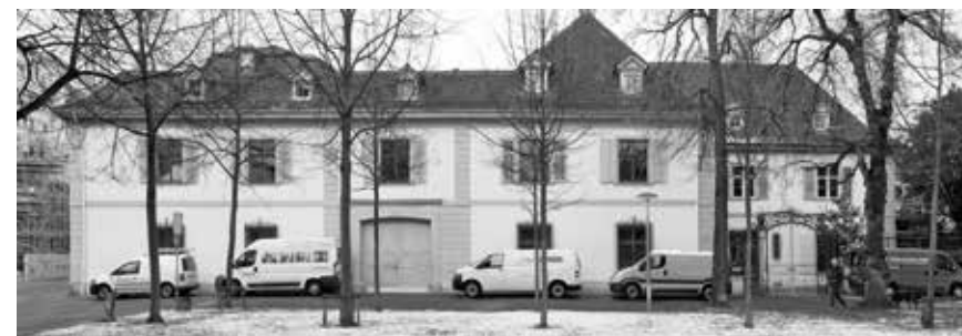
8 - Die Fassade des heutigen Bockstecherhofs ist, wie schon zu Büchels Zeiten, durch rustizierte Lisenen und ein Gurtgesims gegliedert. Ein Traufgesims mit Karnies-Profil und Zahnschnitt verleiht dem Bockstecherhof seine barock-klassizistische anmutende Erscheinung.
