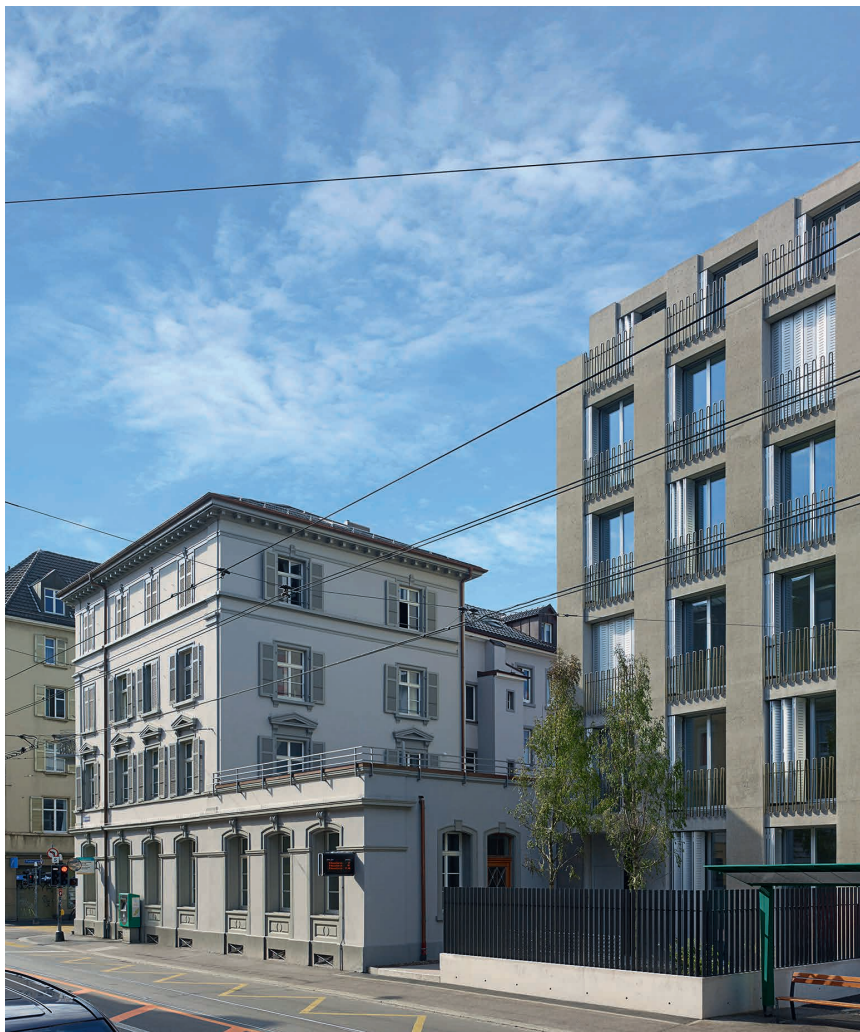
Altbau und Neubau: Fassade Strassenseite
