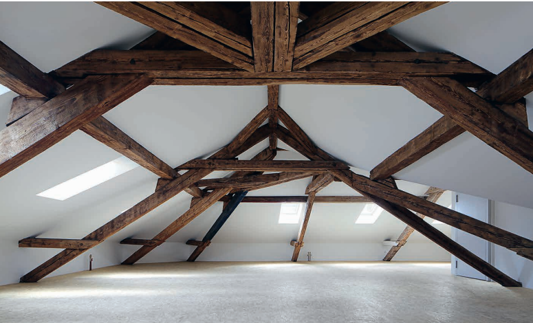
Gewerberaum Erdgeschoss, Altbau
