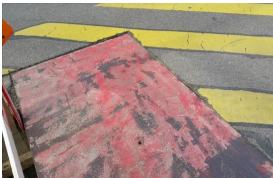
Versenkte Stahlplatte in Fahrbahn
