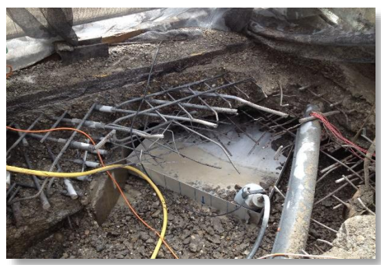
Durchtrennen statischer Brückenbewehrung
