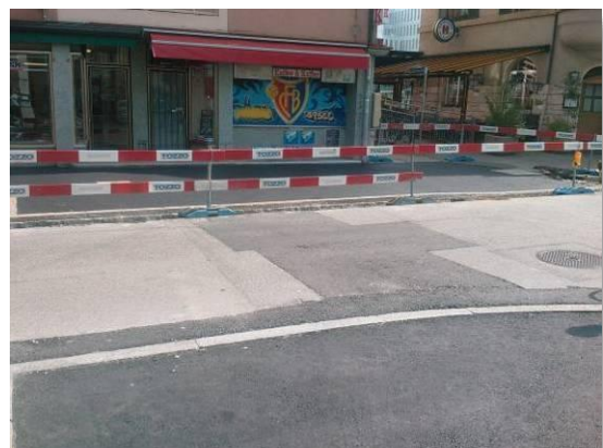
Tragschicht: Flick an Flick im Kreuzungsbereich
