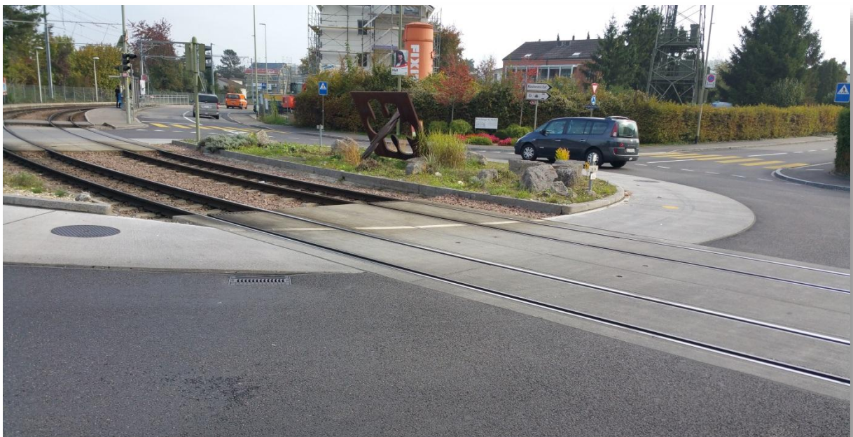
Mögliche Kreisgestaltung mit Tramdurchführung (Randmarkierung fehlt hier)
