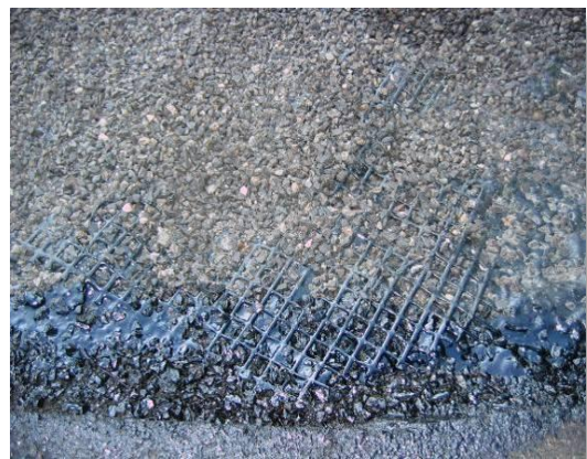
Stressabsorbierende Mastix Inlay (SAMI) spannungsabsorbierende Membrane
