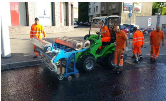
Carbophalt-Netz wird in einem Kreisel verlegt
