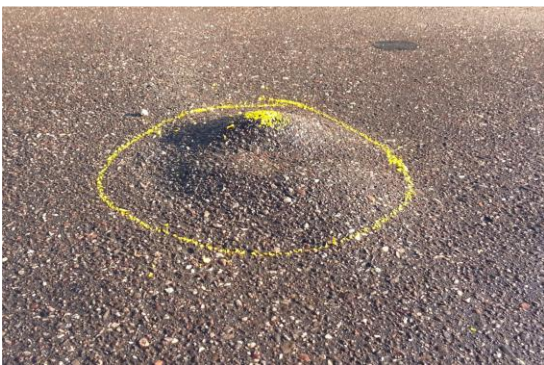
Dampfblase unter Gussasphalt ("Warze")
