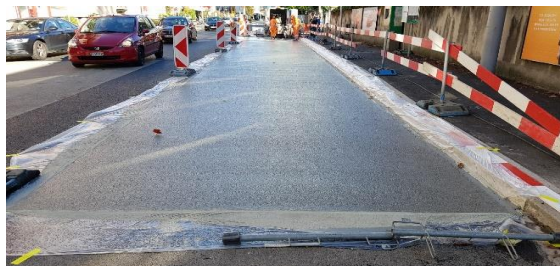
Frisch eingebauter VB11 (hier das Produkt CONFALT)
