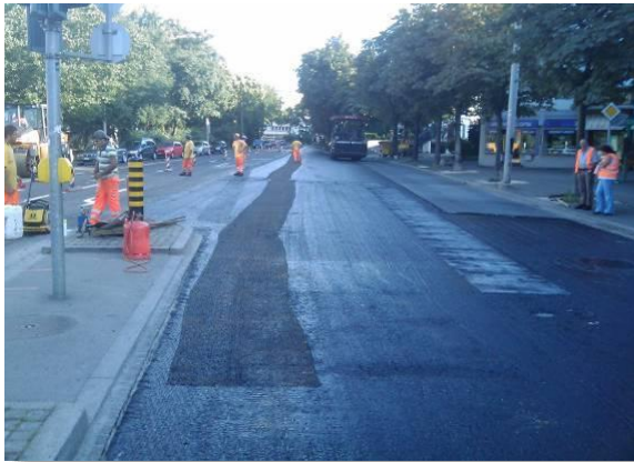
Verlegtes Carbophalt-Netz
