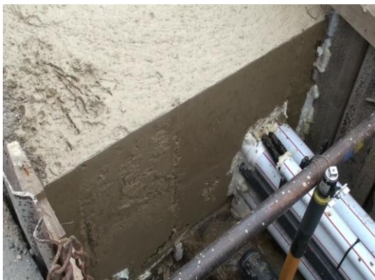
Flüssigboden nach Ausbau des Schotts
