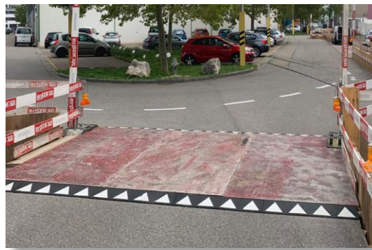
Aufgelegte gesicherte Stahlplatte mit System FLEYG
