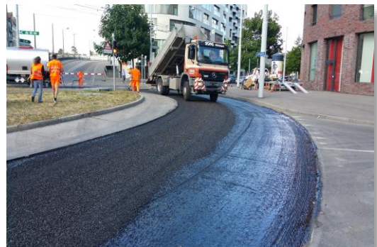
SAMI mit vorumhülltem Splitt wird eingebracht
