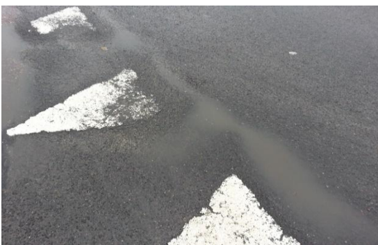
Übermässiger Abrieb in 3-jährigem Testbelag
