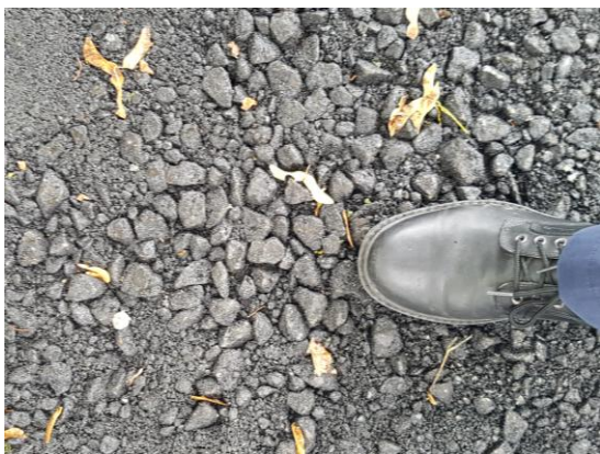
Entmischte "definitiv" eingebaute Tragschicht
