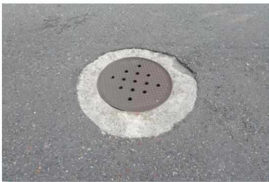
Beton statt Belag (Blick auf Binderschicht)
