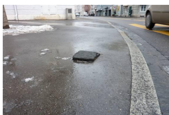
Frosthebung (keine Frostsicherheit)
