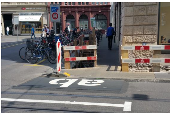
Versenkte Holzdielen mit angerampter Stahlplatte
