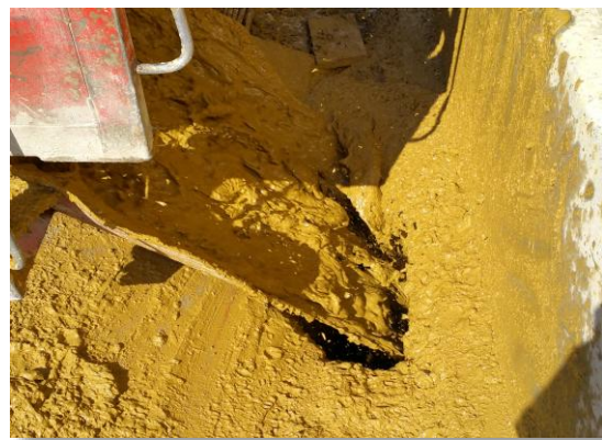
Verfüllen von unerwünschten Hohlräumen (Rühlwand)
