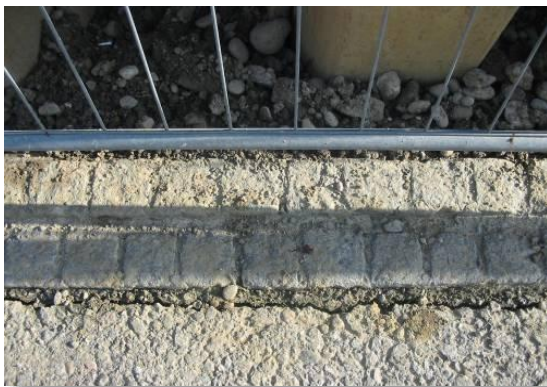
Abgehängter Randabschluss (Baugrube)
