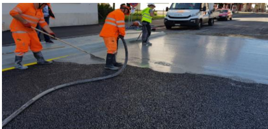
Verfüllen des bituminösen Belags mit der Schlämme
