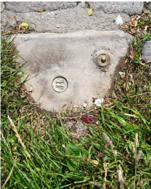
Kantonsgrenzpunkt Nr. 77: Der Granitstein aus dem Jahr 1893 musste durch einen Kantonsgrenzbolzen ersetzt werden, da der Stein mehrfach umgefahren worden war.
