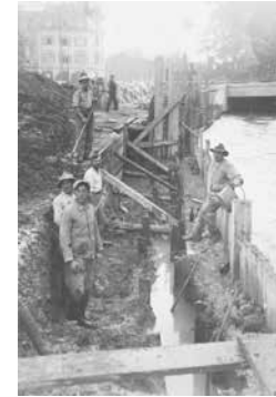
S. 8 und S. 12 BSL 1032 1-1-3 2 Arbeiter bei Arbeiten im Graben mit Stützmauern bei der Korrektion St. Albanteich Zürcherstrasse 1930 Verfertiger unbekannt
