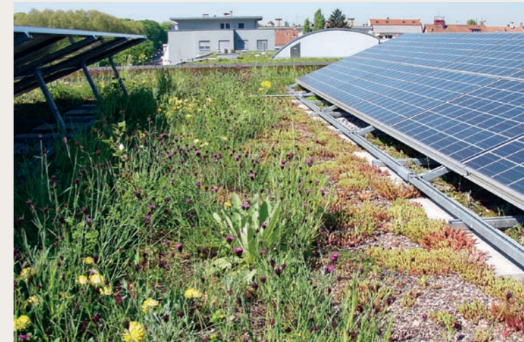
Kombination von Dachbegrünung mit Solaranlage vollflächig Foto: Stephan Brenneisen
