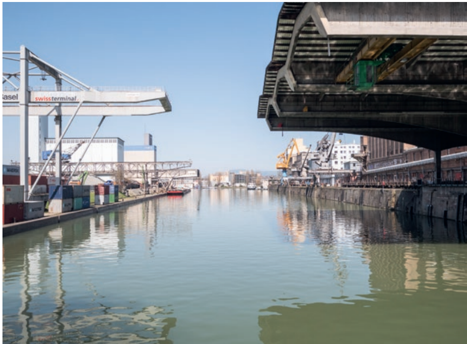
Hafenbecken mit Kränen und Silospeichern Richtung Norden
