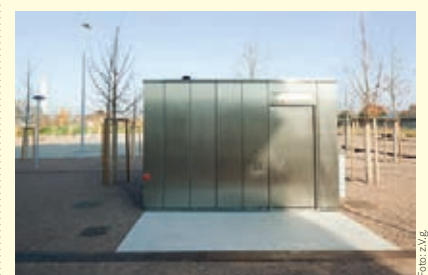
WC-Anlage auf der Erlenmatt
