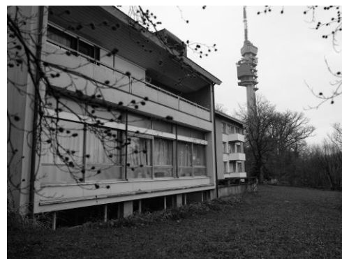
Abbildung 41: Südfassade der Erweiterungen aus den 1960er-Jahre im Stil der Nachkriegsmoderne (Aufnahme Metron 2023)
