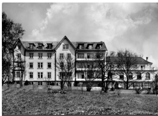
Abbildung 40: Südfassade 1950er-Jahre mit Erweiterung um drei Achsen zw. Hauptbau und Saalbau (Postkarte)
