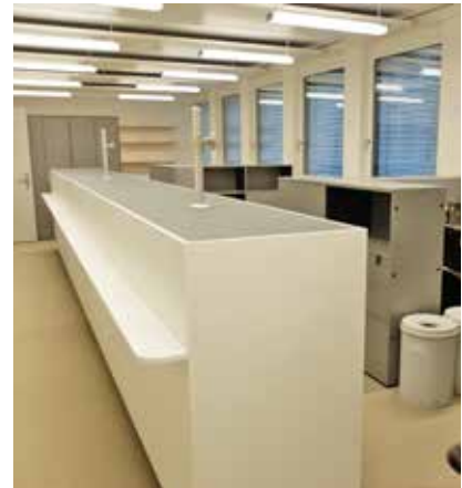
Einbau des Kundenzentrums an der Dufourstrasse 40.
