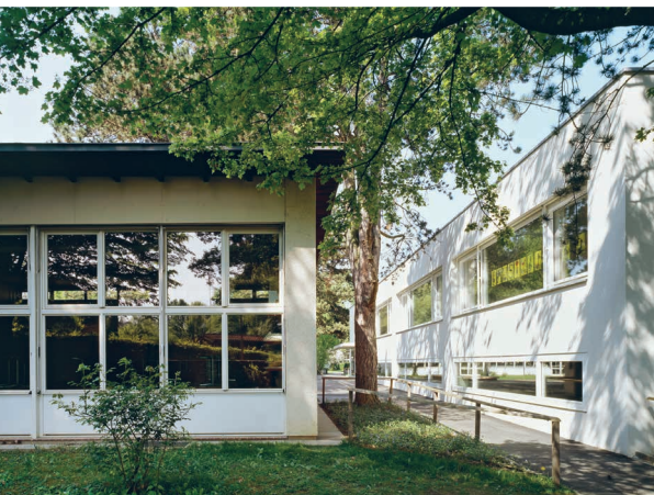
Trakt 5 und Trakt 6
