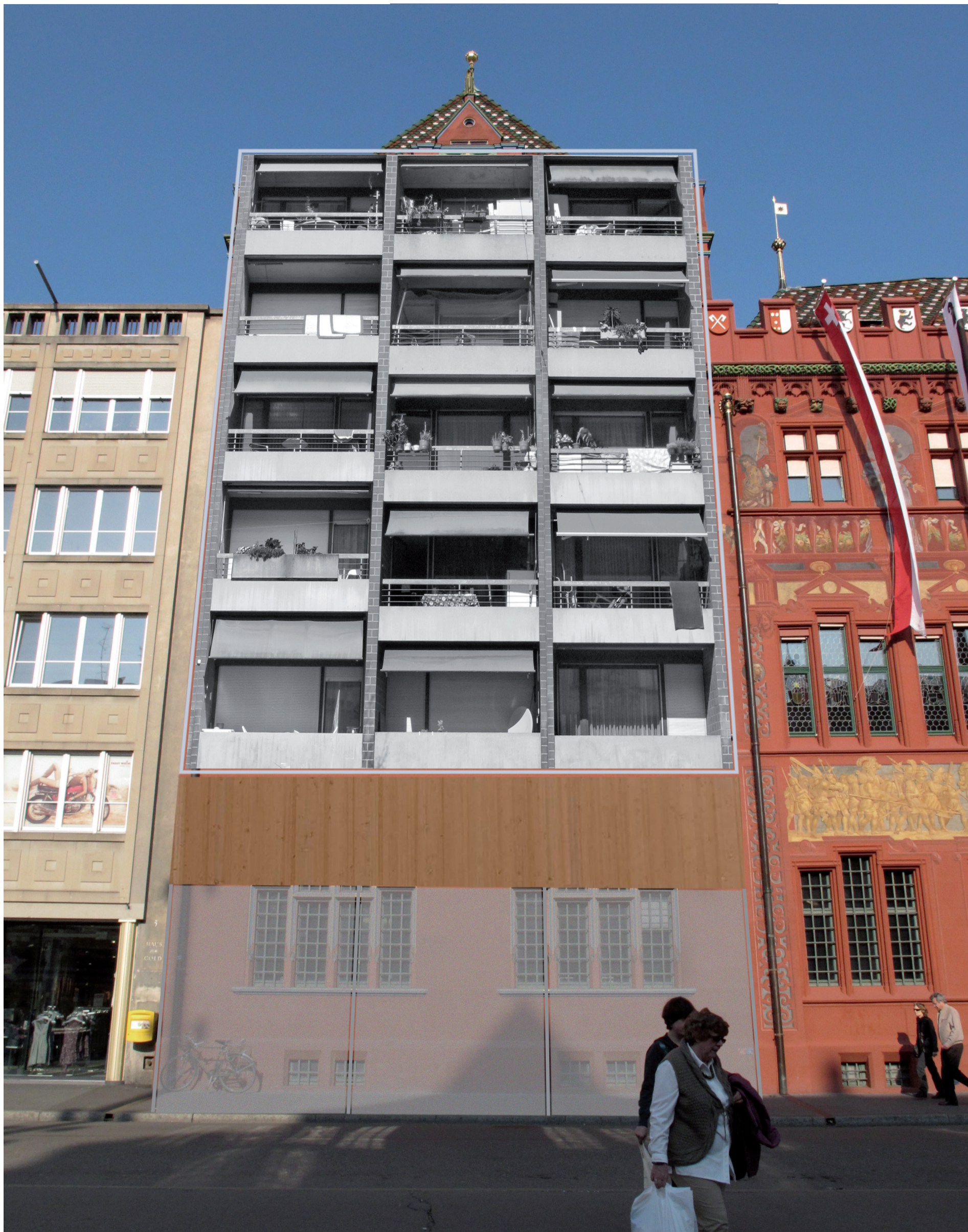
Frontaler Standpunkt zur Fassade in 20 Metern Entfernung
