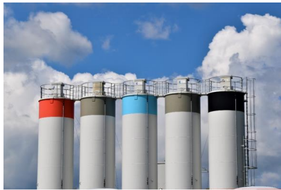
Arbeiten in Silos
