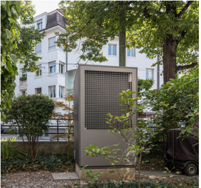
Wärmepumpe im Vorgarten (Ansaugung resp. Ventilator strassenseitig), Pufferspeicher im Keller und Boiler im Nebenraum.
