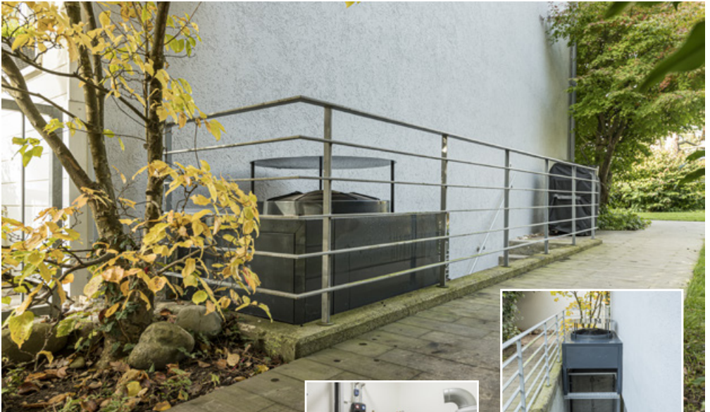
Schwabender Einbau der Ausseneinheit beim Kellereingang, Heizungskeller mit Heizungspeicher und Wärmepumpenboiler.
