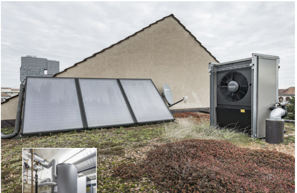
Solaranlage und Wärmepumpe auf dem Flachdach, Kombispeicher und Innenteil der Wärmepumpe im Heizungskeller.
