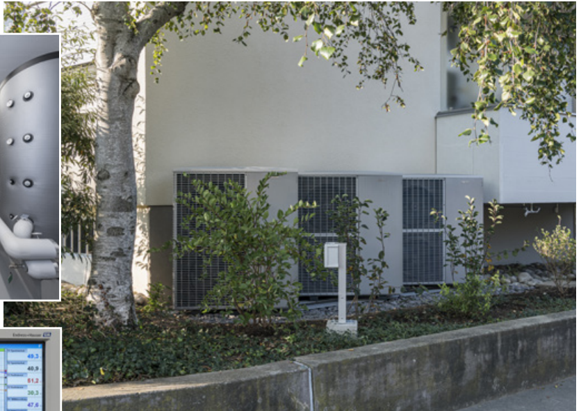
Speicher im Heizungskeller, versetzt angeordnete Ausseneinheiten im Vorgarten, Zähler des Messkonzepts.
