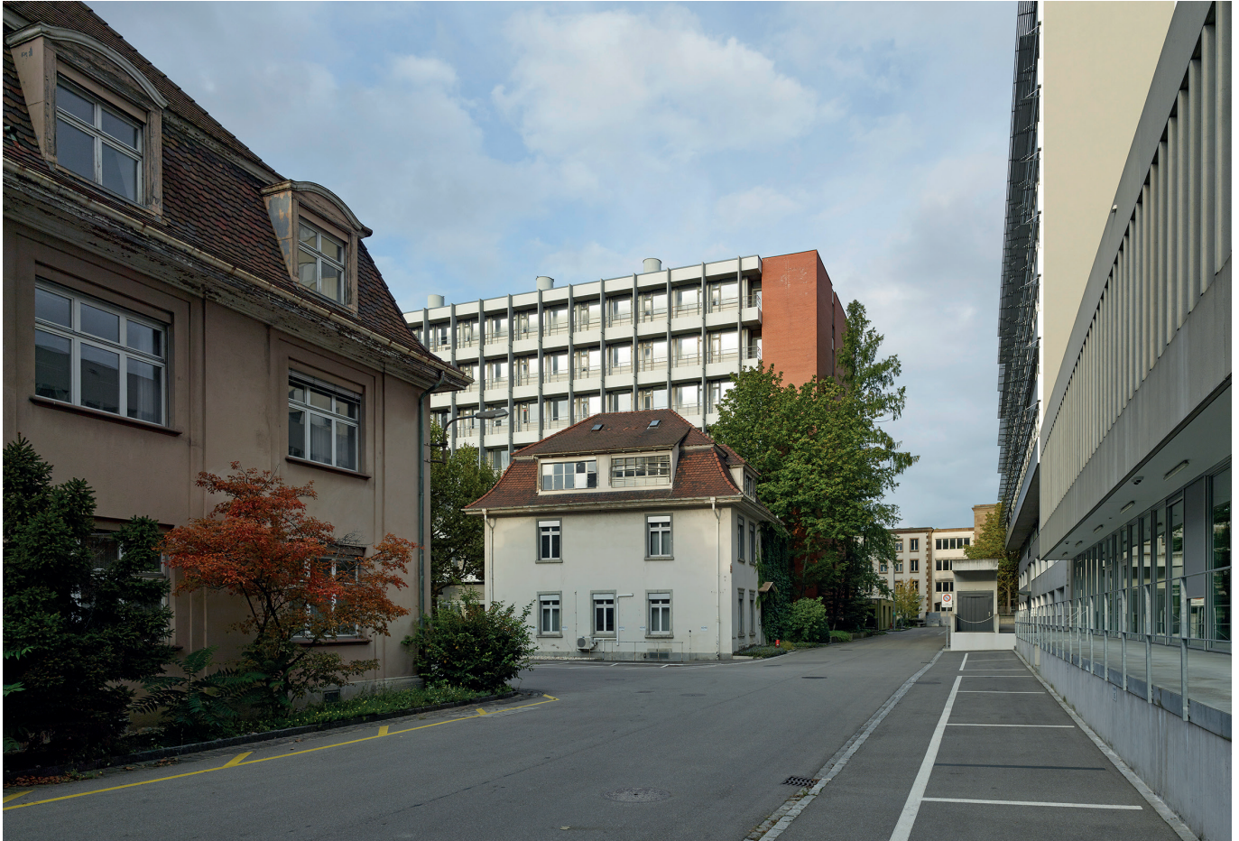
Situationsfoto Bleichstrasse, Blick in Richtung Badischer Bahnhof
