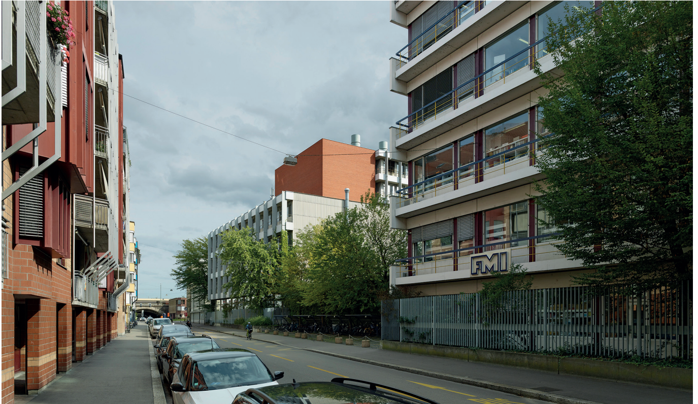
Situationsfoto Maulbeerstrasse, Blick in Richtung Badischer Bahnhof
