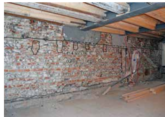
Die südliche Brandmauer im Erdgeschoss aus der Zeit vor 1400. Blick in Richtung Hinterhof. Kleinteiliges Mauerwerk mit Backsteinreihen in regelmässigen Abständen. Markiert sind die Mauerkrone und die zugemauerten Löcher der Deckenbalken. Zustand Februar 2013.
