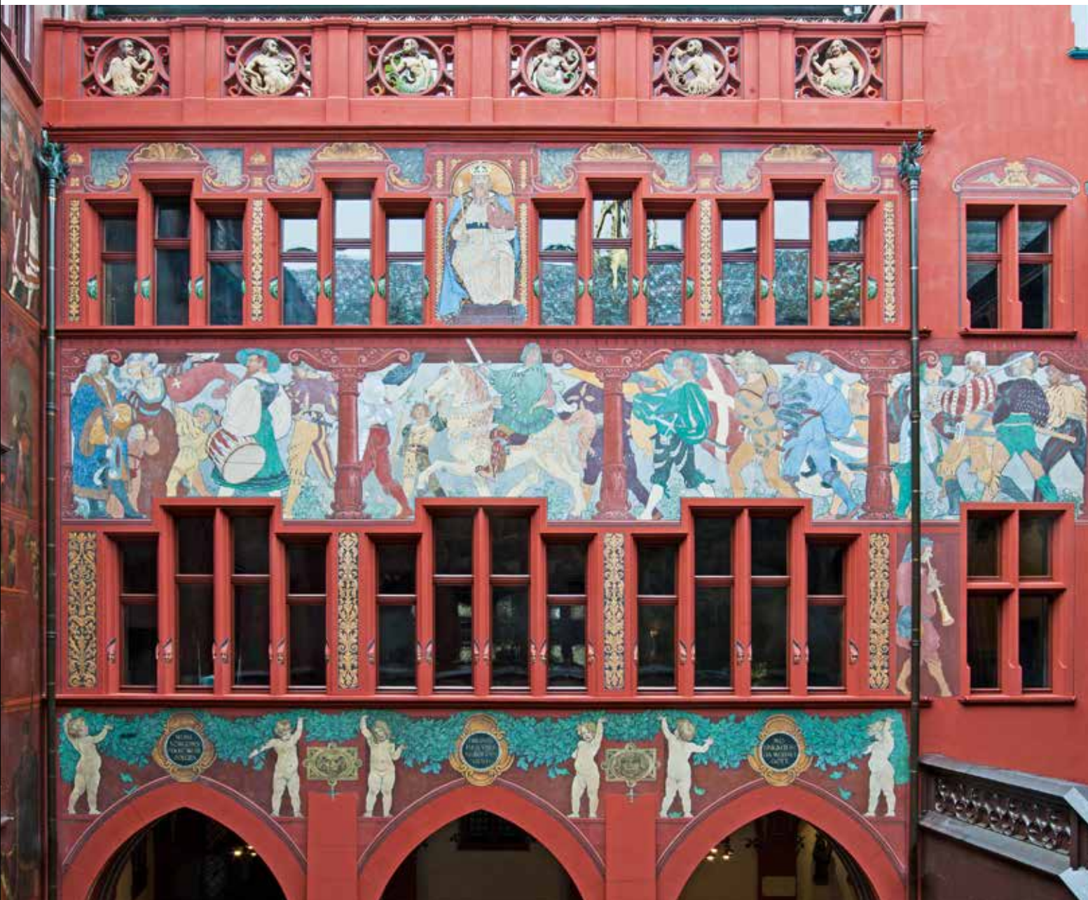
Rathaus Basel. Hoffassade des Grossratsgebäudes nach der Restaurierung 2013. Die Malereien von Wilhelm Balmer zeigen den Einzug der Eidgenossen in Basel am Heinrichstag 1501. Bei der Restaurierung wurde u. a. die verblasste Architekturmalerei von Franz Baur retuschiert und nachgezogen, um deren struktur- und raumbildende Wirkung wieder besser erkennbar zu machen.
