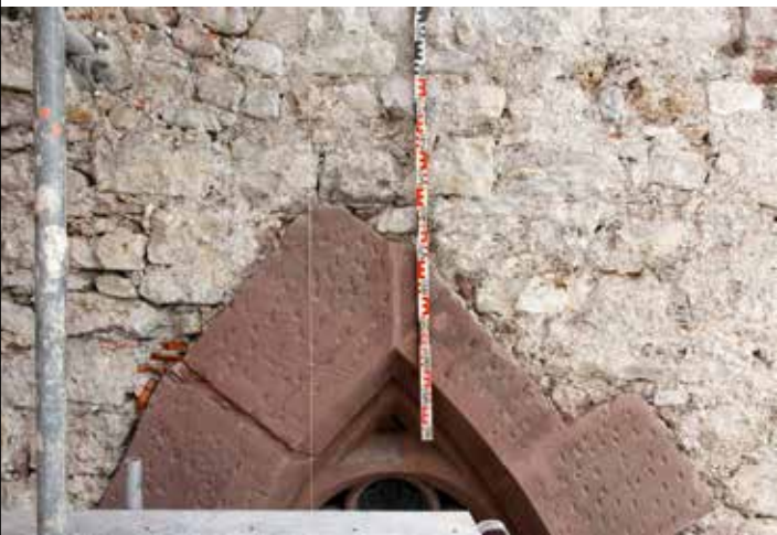
Spitze des westlichen Fensters in der Südfassade des Chors. Die unterschiedlich grossen Steinformate sind original im Mauerwerk von 1300 eingebunden und formen im Fensterlicht einen präzisen Spitzbogen mit Masswerk.
