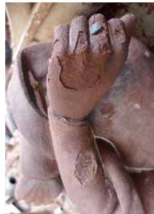
Links: Zwei Schadensbilder am Westportal vor der Restaurierung. Auf dem Kopf eines Propheten hat sich Schmutz abgelagert und verhärtet (links). Die Hand eines Propheten, der eine Schriftrolle hält, zerfällt und sandet aus (rechts).
