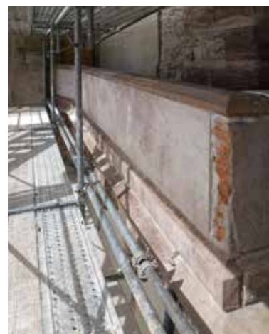
Die im 19. Jahrhundert in Backsteinmauerwerk erneuerte Brüstung des stadtseitigen Umgangs (ursprünglich aus dicken Steintafeln) hat um 1933 durch einen raffiniert behandelten Verputz das täuschend echte Erscheinungsbild von Naturstein erhalten. Der von Frost, Salzen und Feuchtigkeit völlig mürr gewordene Abschnitt der Südseite wurde nun in Degerfelder Stein ersetzt, dem für das Spalentor charakteristischen, aber seit Generationen nicht mehr abgebauten Material, nachdem Blöcke besonderer Grösse auf dem «antiquarischen» Markt ergattert werden konnten. Fotos während und nach dem Versetzen der Werkstücke.
