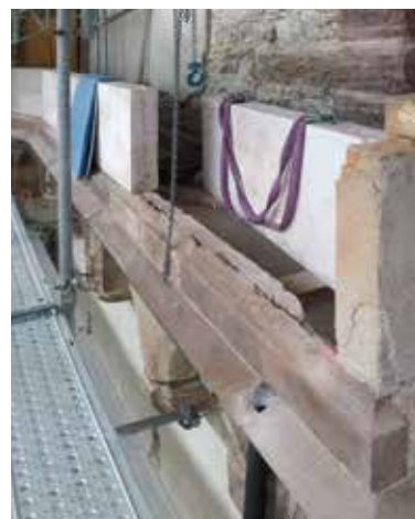
Die im 19. Jahrhundert in Backsteinmauerwerk erneuerte Brüstung des stadtseitigen Umgangs (ursprünglich aus dicken Steintafeln) hat um 1933 durch einen raffiniert behandelten Verputz das täuschend echte Erscheinungsbild von Naturstein erhalten. Der von Frost, Salzen und Feuchtigkeit völlig mürr gewordene Abschnitt der Südseite wurde nun in Degerfelder Stein ersetzt, dem für das Spalentor charakteristischen, aber seit Generationen nicht mehr abgebauten Material, nachdem Blöcke besonderer Grösse auf dem «antiquarischen» Markt ergattert werden konnten. Fotos während und nach dem Versetzen der Werkstücke.
