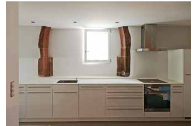
Blick in die Küche des 2. Obergeschosses mit freigelegten Gewänden des einstigen Kirchenfensters.
