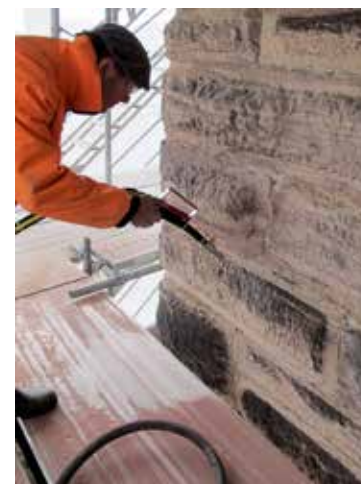
Bei der behutsamen Reinigung des Natursteins mittels Strahlverfahren wurden dunkle Schmutzablagerungen nur soweit reduziert, dass eine gewisse Patina und damit auch die Wirkung des Oberflächenreliefs bewahrt blieben.
