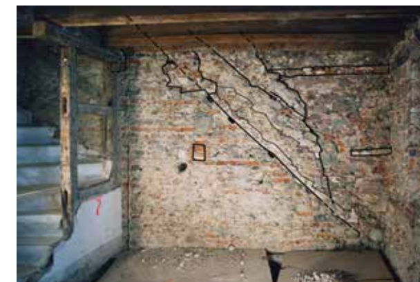
Im 2. Obergeschoss ist in der nördlichen Brandmauer nach Entfernung des Verputzes die aus der Zeit um 1400 stammende Giebelmauer des Nachbarhauses samt Löchern von Dachlatten und Mauerstreifen von später erfolgten Aufstockungen zu erkennen.
