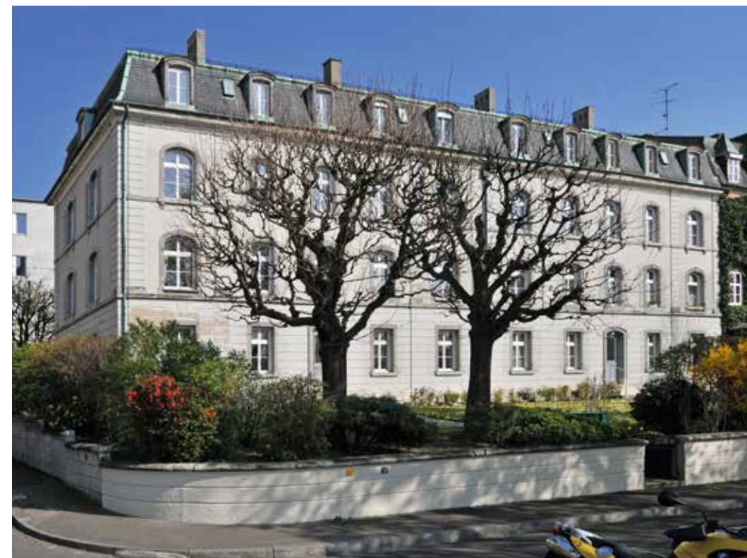
Das 1894 von E. Vischer und Fueter projektierte Mehrfamilienhaus für die «AG für Erstellung billiger Wohnungen» am Unteren Rheinweg 132/134. Fotos 1960 (Originalzustand) und 2013.
