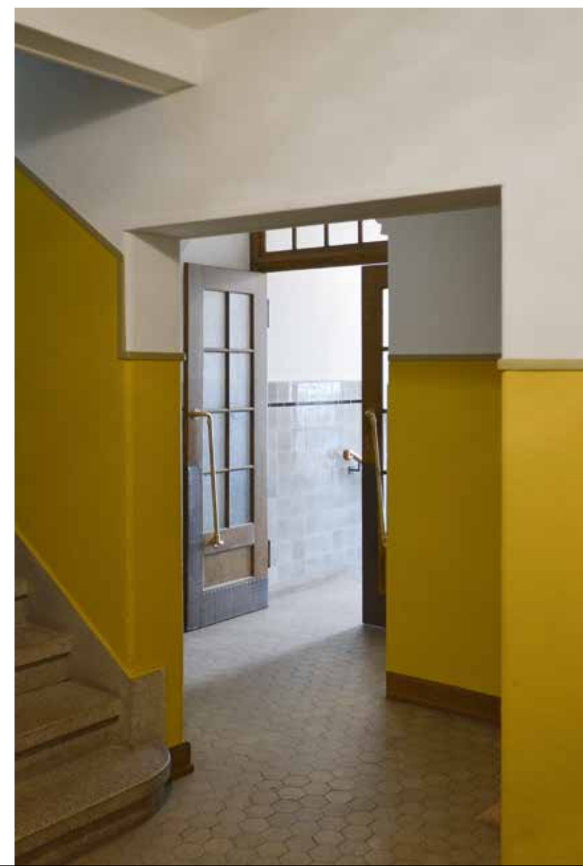
Unten: Die aus der Bauzeit stammende Materialisierung im Eingangsbereich des Gebäudes wurde beibehalten und sorgfältig aufgefrischt: mit Ölfarbe gestrichene Rupfenbespannung der Wände, maseriertes Holzwerk, polygonale Fliesen am Boden, glasierte Fliesen an den Wänden des Windfangs.
