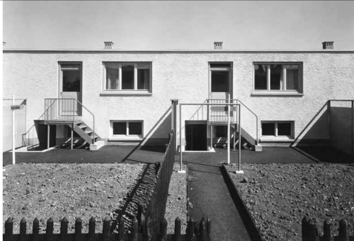
Drei der bestechenden Fotos aus den Serien, die Ochs-Walde und Robert Spreng kurz nach Fertigstellung der WOBA-Siedlung anfertigten. Oben: Block 10 (Bernoulli & Künzel), Rückseite. Mitte: Blick aus einem der Häuser im Block 10 auf den Block 11 (Hermann Baur). Unten: Wohnraum im Block 10 mit «3m»-Möbeln von Mumenthaler & Meier sowie Stühlen der Firma Horgen-Glarus.
