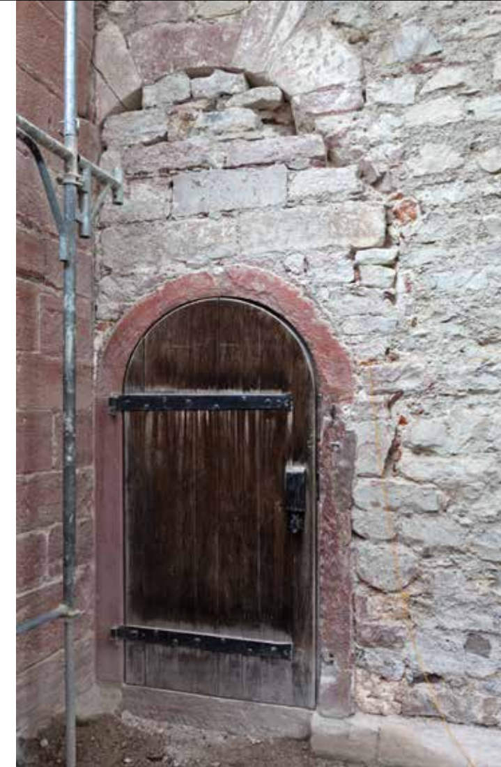
Nordmauer des Chors mit altem Rundbogen über der Rundbogentüre aus der Zeit Stehllins (1845). Der aus grossen Keilsteinen zusammengesetzte Rundbogen war Teil einer Verbindungstür zwischen dem Chor und der ehemaligen Marienkapelle.
