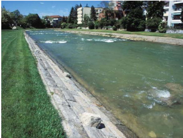
Abbildung 19: Hart verbauter Böschungsfuss der Birs vor der Revitalisierung (links), sowie grosse Habitatdiversität im Uferbereich nach BirsVital (mitte, rechts).
