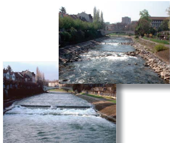
Abbildung 20: Birkopf mit Schwellen im Februar 1995 (links) und nach der Sanierung durch Blockrampen im April 2002.
