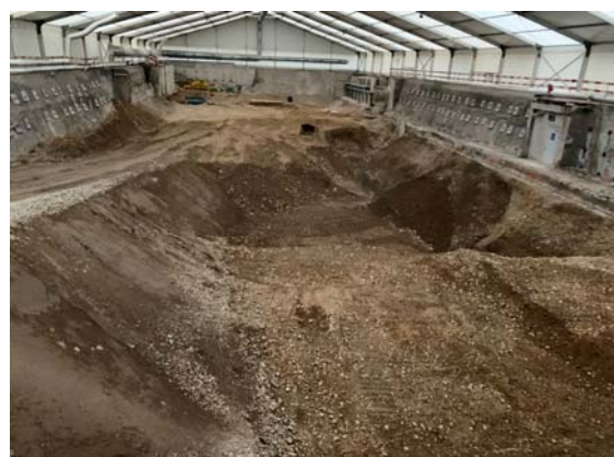
Abb. 3: Sohle mit Zufahrtsrampe Blickrichtung W
