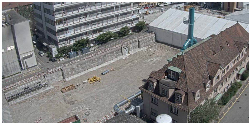
Abb. 7: Endzustand nach Zeltrückbau (Quelle webcam WRO)
