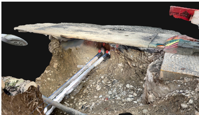
Stahlplatte, Pix4D-Ansicht: Aufnahme ohne Öffnen der Platte
