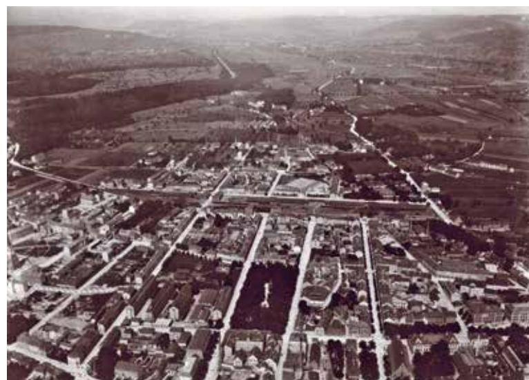
Das Kleinbasel wächst gegen Osten. Im Vordergrund die Claramatte, links die Seidenbandfabrik Vischer & Co. Weiter hinten der alte Badische Bahnhof auf dem heutigen Messeareal. Ballonaufnahme von Eduard Spelterini, um 1900–1906.
