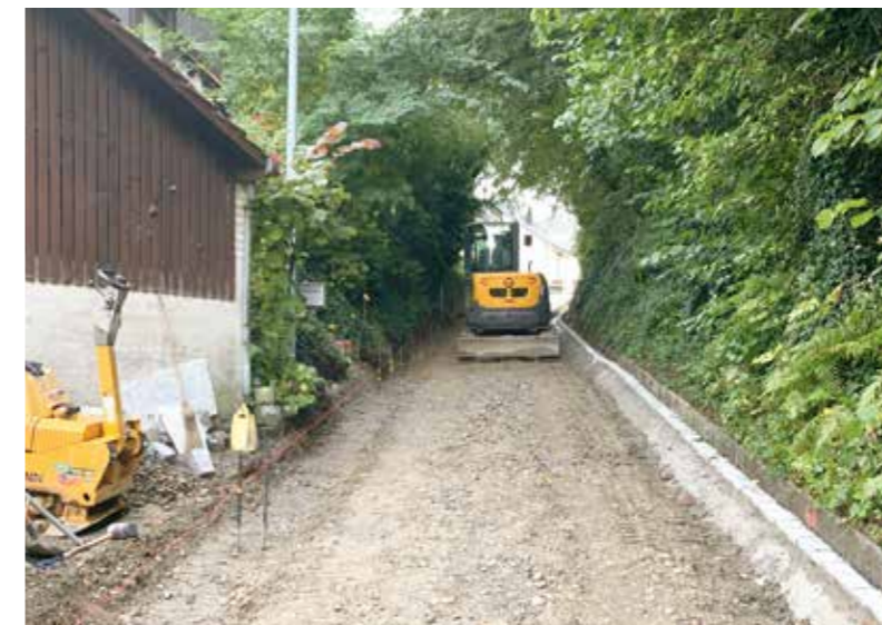
Einbau der Fundationsschicht und der Randsteine im Bereich zwischen der Oberen Dorfstrasse und dem Mennweg, Foto: Andres Linder
