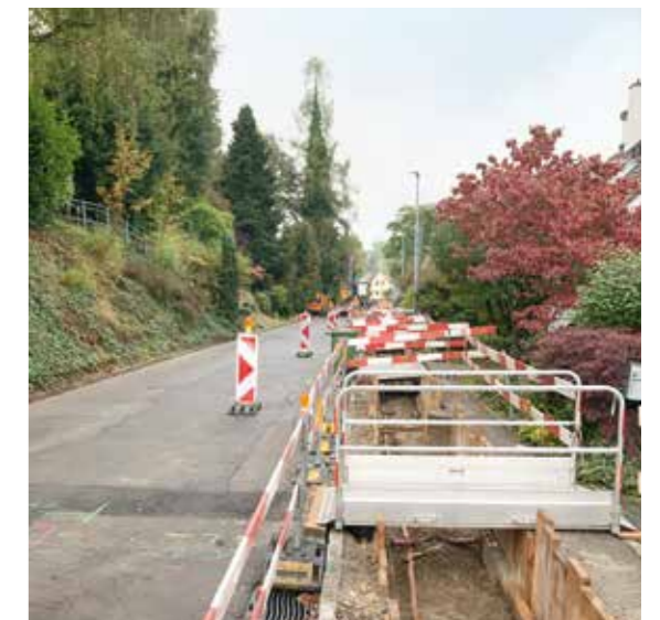
Bau der Elektroleitung im Trottoir an der Baiergasse, Foto: Andres Linder
