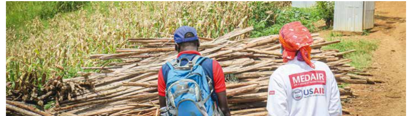
Bau einer sanitären Anlage für Binnenvertriebene in Bunia, Provinz Ituri, Foto: Jonathan Kyle, © Medair
