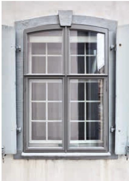
Der exakte Einbau in die keineswegs uniforme alte Rahmenarchitektur erfordert individuelle Massarbeit (oben). Dauerhaft montierte Vorfenster ermöglichen auch eine optimierte Dichtung des Anschlags zwischen Holzrahmen und Steingewände (rechts). Die gepflegten und von nutzungsbedingten Eingriffen verschonten Barockfenster sind veritable Schreinerantiquitäten (rechte Seite).
