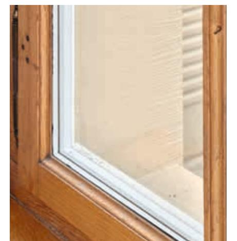
In den Korridoren vorkommender Typus mit holzsichtiger und sprossierter Innenseite (in den Zimmern gestrichen und unsprossiert). Zur Vermeidung von Kondensatbildung ist für eine Durchlüftung zwischen der neuen inneren Isolierverglasung und der alten äusseren Einfachverglasung gesorgt worden.
