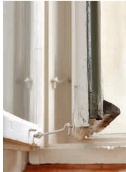
Rittergasse 4, ehem. Untere Realschule, Kastenfenster von 1887, Details. Links: Der Flügelfalz ist als «Wolfsrachen» ausgeführt, eine im späten 19. Jahrhundert gebräuchliche Form, bei der die Stirnseite des Flügelrahmens einerseits als Wulst und auf der Gegenseite als Kehle ausgeführt ist. Rechts: Bewegliche Verbindungshaken erlauben zur Sicherung die Verbindung von Aussen- und Innenflügel im geöffneten Zustand.
