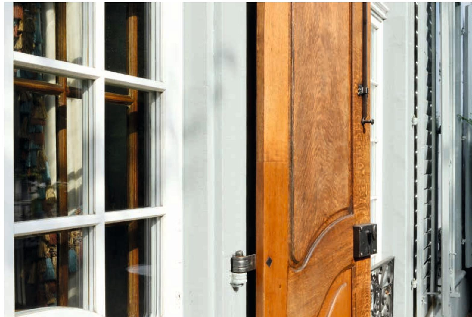
Bei den Restaurierungsarbeiten wurde die Gebäudehülle des Pavillons samt aller Gestaltungselemente und Details äusserst sorgfältig instand gesetzt. Abgesehen von umfassenden Malerarbeiten wurden die Schlagläden teilweise zerlegt und schadhafte Teile erneuert, die Beschläge und Schlösser wieder funktionstüchtig gemacht, die kunstvoll verzierten Gitter an den Fensterbrüstungen (linke Seite) gereinigt und repariert.
