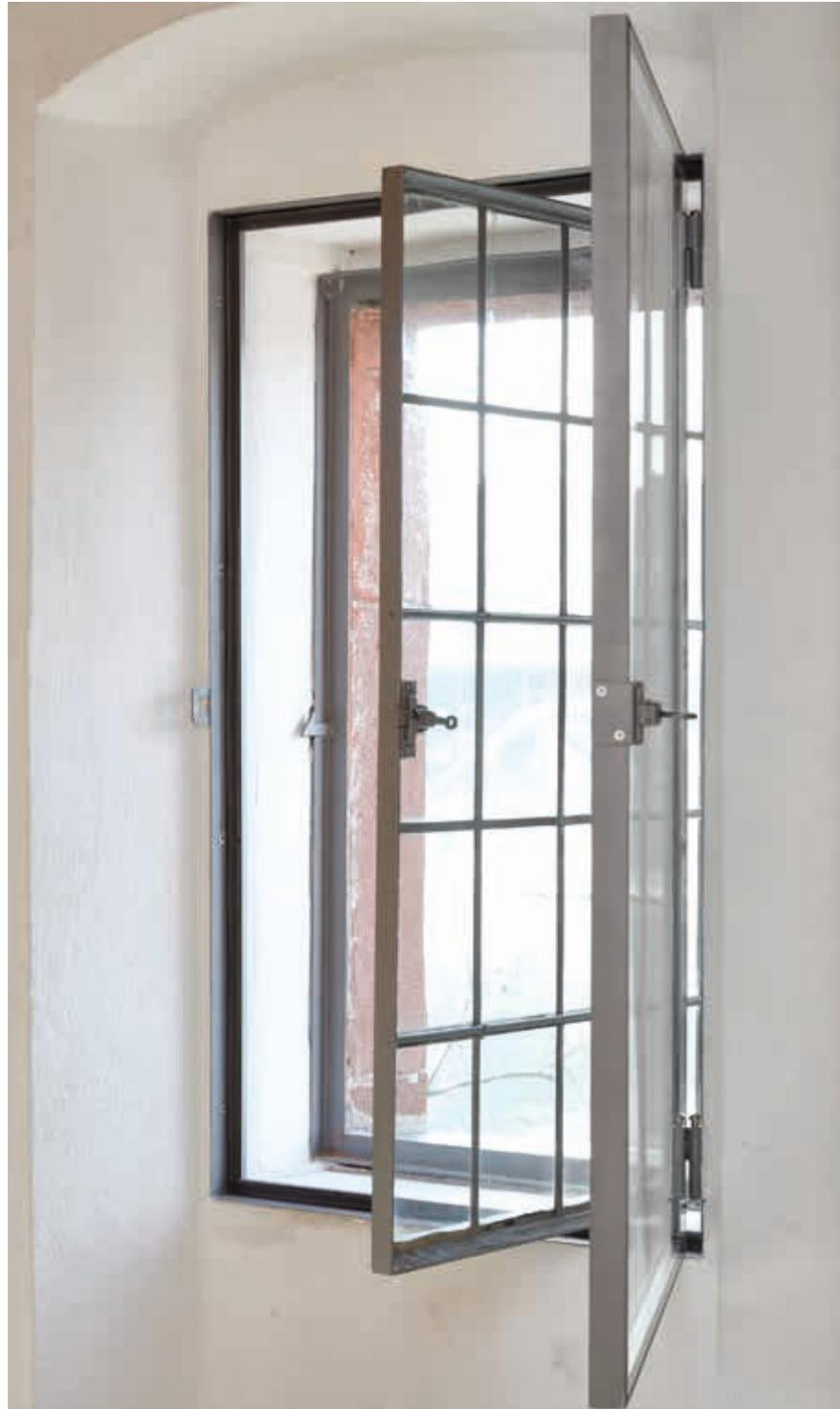
Kastenfenster als traditionelle Lösung: Zugunsten der ganzjährigen Raumnutzung erhielten die feingliedrigen, bleisprossierten Stahlfenster (1920er Jahre) des Kleinbasler Pulverturms eine ebenbürtige Ergänzung durch ein zusätzliches, isolierverglastes Innenfenster.
