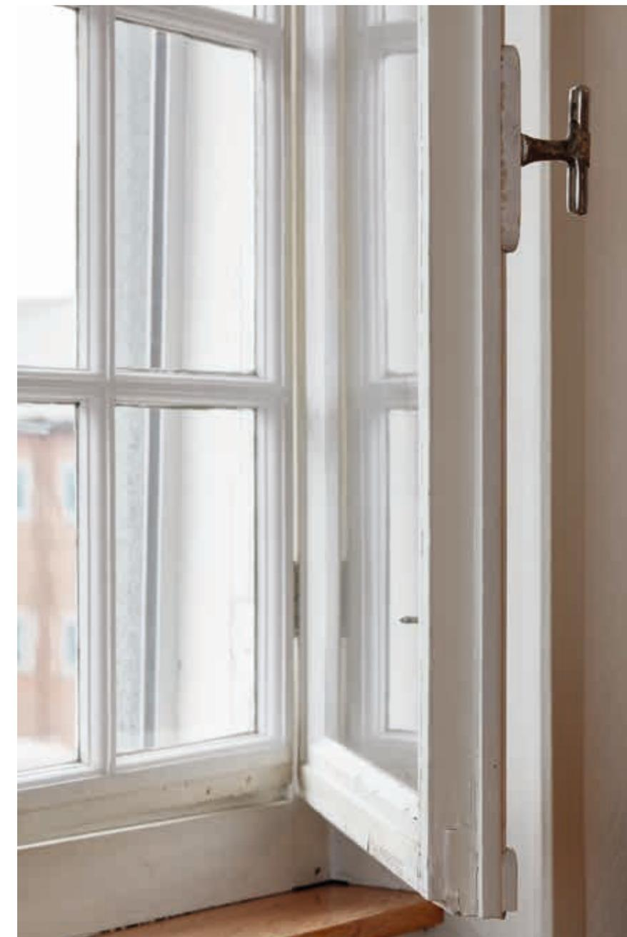
Der rechte Flügel eines zum Reinigen geöffneten Verbundfensters (oben) mit sprossierter äusserer und nicht sprossierter innerer Glasebene. Die zusätzlich eingefügte flexible Dichtungslippe ist im Ausschnitt links als senkrechter grauer Streifen im Rahmenfalz erkennbar.
