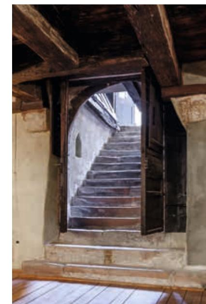
Eine stimmungsvolle Altertümlichkeit zeichnet den doppelgeschossigen, um 1270 entstandenen Keller aus. Seine Innenkonstruktion aus mächtigen Eichenhölzern umfasst die Deckenbalken und ein Tragwerk aus Unterzug und Stützen. Links: Blick in den tieferen Kellerraum. Oben: Verbindungstreppe zum oberen Keller mit Rundbogenportal und zweiflügligem Holztor.
