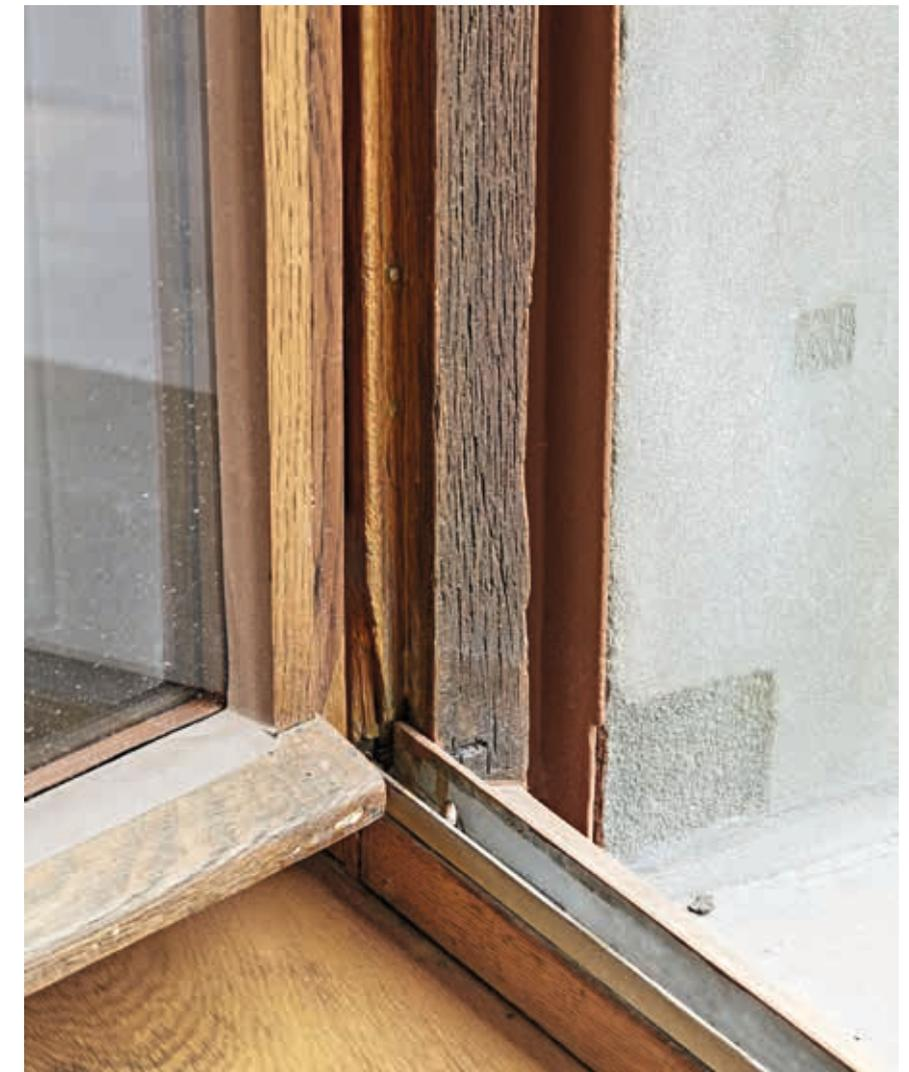
Das bei einer früheren Sanierung am unteren Rahmenfalz eingebaute Aluminiumprofil hat sich funktionell bewährt und ist bei der aktuellen Massnahme beibehalten worden.
