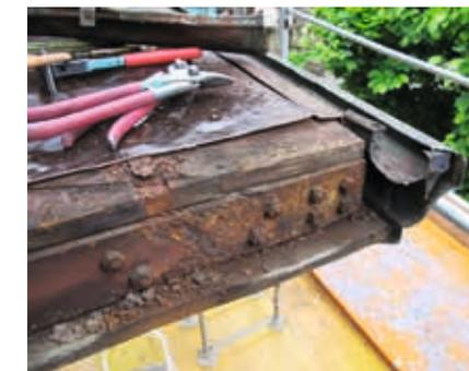
Oben: Nicht nur das ornamentale Oberflächenrelief am Vordach des Fürstenvavillons war durch Schmutzkrusten und Korrosion unkenntlich geworden, auch die tragende Unterkonstruktion zeigte erhebliche Schäden. Linke Seite: Die Eingangspartie des Fürstenvavillons nach Reparatur- und Instandsetzungsarbeiten an Bauskulptur und Vordach.
