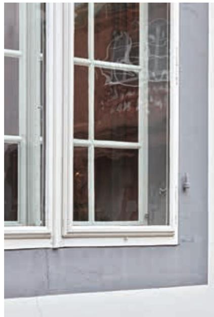
Zum Einbau einer dünnen Isolierverglasung wurden die Vorfenster aussen geringfügig aufgedoppelt. Der beabsichtigt unregelmässige Spiegeleffekt des gezogenen äusseren Glases ist oben und beim Ausschnitt links erkennbar. Rechts: Rahmenfalz des Innenfensters mit neu hinzugefügter Dichtung.
