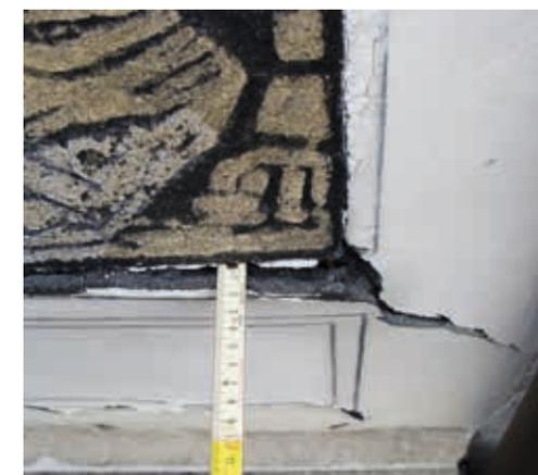
Vor Beginn der Arbeiten waren zahlreiche bedrohliche Schadensbilder zu konstatieren wie z.B. beim Knabenchor die flächig ausbauchende Verputzschicht (oben) in Verbindung mit partiellen Rissen und Deformationen (oben rechts).
