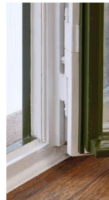
Angesichts der grossen Fensterflächen bei Schulbauten kann mit Nachrüstungsmassnahmen eine erhebliche Verbesserung der energetisch relevanten Dämmung erzielt werden. Bei den Verbundfenstern des Basler Insel-Schulhauses (1908) wurde deshalb der äussere, sprossierte Flügel in Isolierverglasung erneuert.
