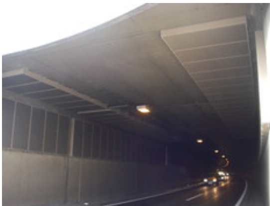
Abb. 1: Unterflurtrasse Lendorf im Bundesland Kärnten. Die Filter sind an Decken und Wand des Tunnelportals angebracht
