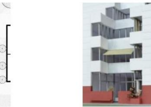
Der rüstartige Betonrahmen mit Holz- und Metallfensterrahmen
