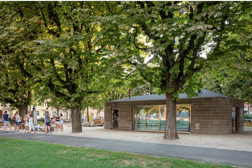
Gebäude eingebettet in den Park
