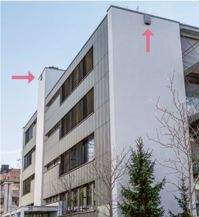
An zwei Gebäudeseiten angebrachte Fledermauskästen, um Unterschiede des Mikroklimas zu berücksichtigen. Foto: Elena Zihlmann
