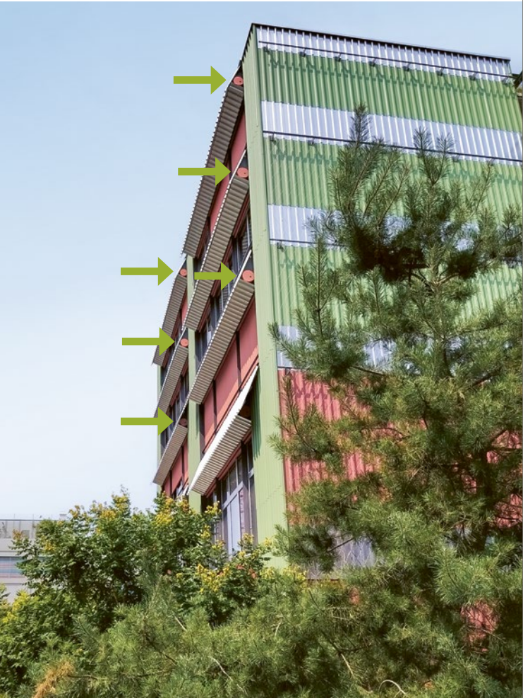
Integration von Seglernistkästen in das Design des Gebäudes. Foto: Natalie Jeanneret
