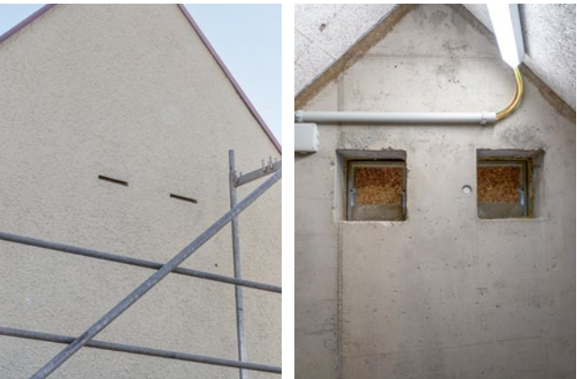
Aussen- und Innenansicht des Einflugs in ein Fledermausquartier. Fotos: Elena Zihlmann
