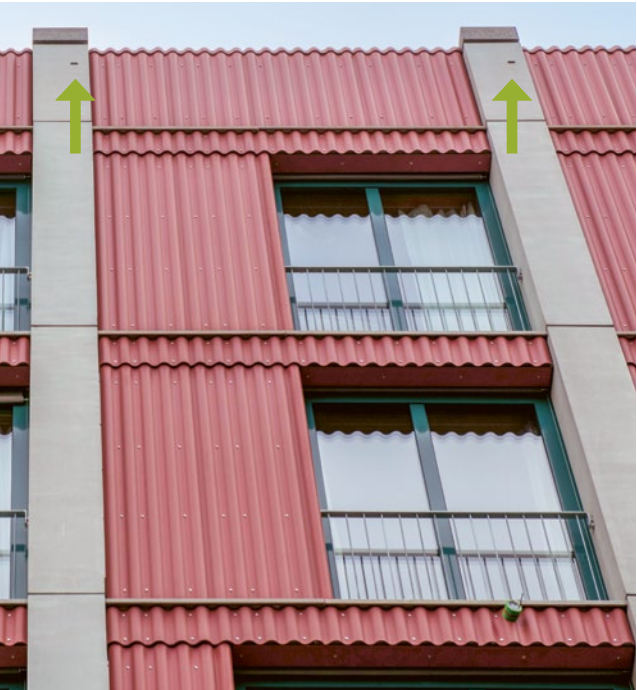
In Fassade integrierte Seglerkisten. – Foto: Elena Zihlmann
