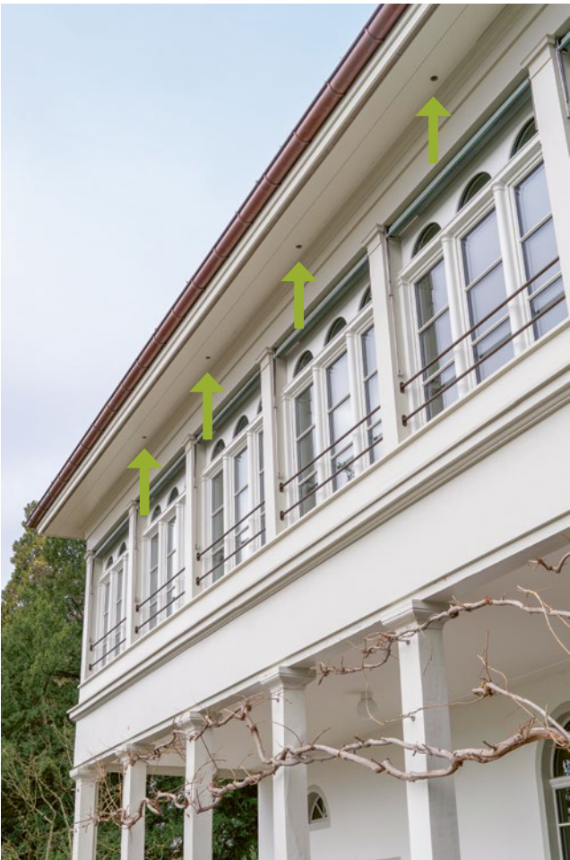
Während einer Renovation wurden Zugangslöcher in den Gesims-kasten geschaffen. - Foto: Elena Zihlmann
