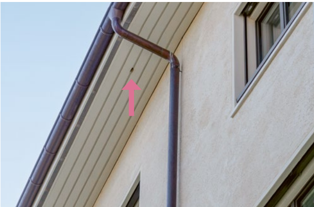
Einflugöffnung für Fledermäuse im Gesimskasten. Foto: Elena Zihlmann
