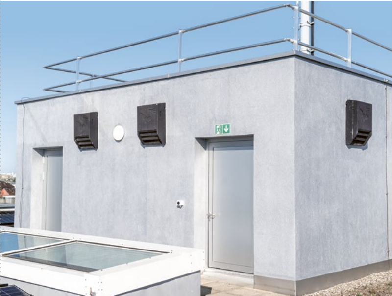
Fledermauskästen an einem Dachaufbau. – Foto: Elena Zihlmann
