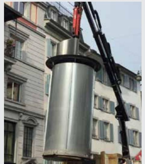
Die Stadtreinigung hebt die vollen Unterflurcontainer mit einem Kran-Kehrrichtfahrzeug aus dem Boden und leert die blauen und grünen Säcke hinten in das Fahrzeug.
