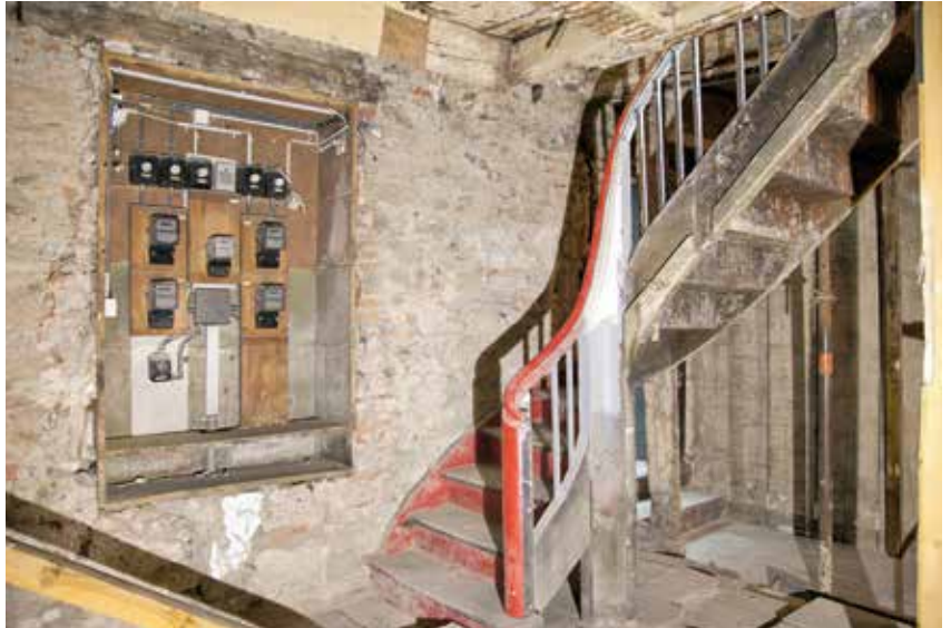
Die Mauernische mit Holzsturz in der Erdgeschoss-Rückwand des Hauses zum Waldshut, später für den Einbau des Holzkastens vergrössert und schliesslich zum Sicherungskasten umfunktioniert.
