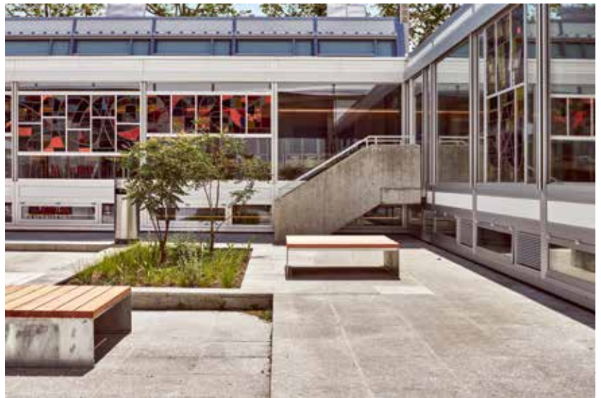
Oben: Musiksaal nach der Sanierung. Um bauphysikalischen und sicherheitstechnischen Vorgaben gerecht zu werden, wurden die Oberflächen in Anlehnung an den Vorzustand erneuert. Unten: Innenhof mit Blick in Richtung Zeichensäle. Die farbigen Glasmalereien von Otto Staiger stehen im Kontrast zur Blankverglasung und tragen zur Lebendigkeit der Innenräume bei.
