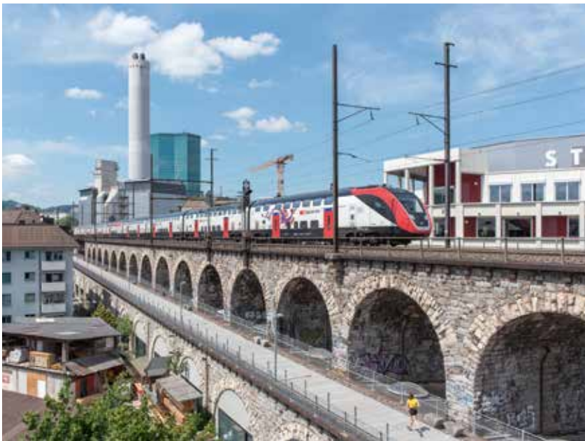
Langlebiges Industriedenkmal – Die 1889–1898 von der Nordostbahn errichtete Anlage des Wipkinger- und Lettenviadukts im Zürcher Stadtkreis 5 – hier auf Fotos von 1945 und 2019 – ist ein imposantes Denkmal der Bau- und Verkehrsgeschichte. Bis heute dient das Bauwerk seiner primären Funktion, wobei die 1989 stillgelegte Lettenlinie in einen Fuss- und Veloweg umgewandelt wurde und die Gewerbe- und Lagerräume in den Viaduktbögen Läden, Gastrobetrieben und einer Markthalle Platz gemacht haben. Das Letzteres mit Gentrifizierung zu tun hat, mag Kritiker auf den Plan rufen; nichtsdestotrotz ist das Viadukt für die Quartierbevölkerung ein hochgradig identitätsstiftendes Bauwerk geblieben; für viele ist es das eigentliche Wahrzeichen des Zürcher Industriequartiers.
