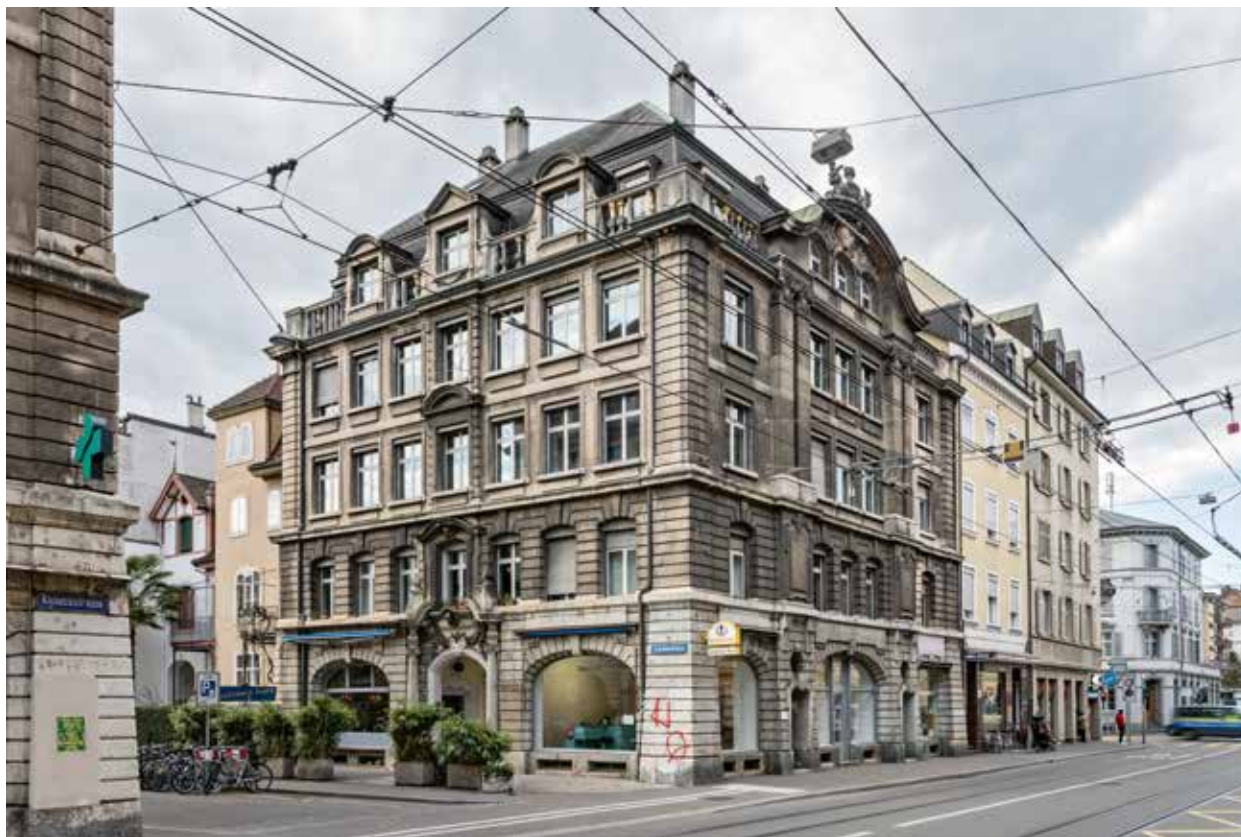
Der mächtige Eckbau Kandererstrasse 35/Klybeckstrasse 29 vor ...
