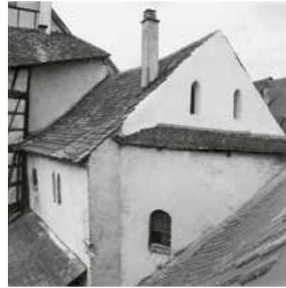
Spitzbogige Fenster aus Stuckmörtel im Obergeschoss und Dach eines Hauses von 1288 an der Hauptstrasse 62 in Rottweil/D.
