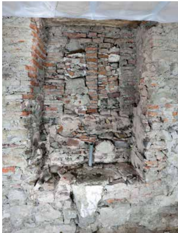
Der Ausbau des Sicherungskastens legte ein Zwillingenster von 1357 frei. Stufenweise vorkragende Backsteine und darauf ein schräg ziehender Stuckmörtel dürften ehemals Spitzbögen ausgebildet haben.
