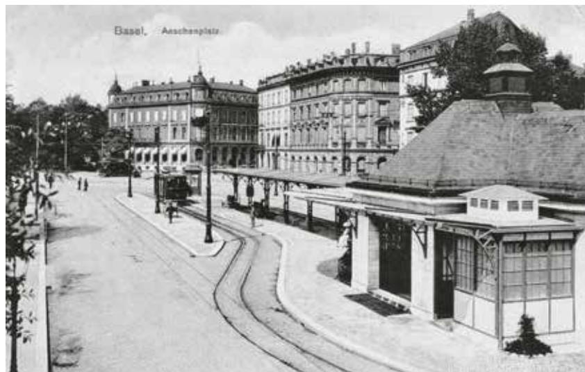
Das 1908 von Gustav und Julius Kelterborn errichtete Stationsgebäude am Aeschenschplatz mit gedecktem Perron und Wendeschleife. Foto kurz nach 1908. Während das Stationsgebäude immer noch steht, hat sich die Häuserkulisse im Hintergrund merklich verändert.
