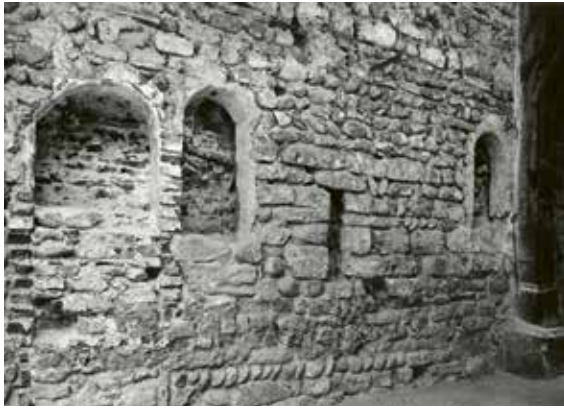
Rundbogige Fenster aus Stuckmörtel (13. Jahrhundert) in der Seitenwand des Rollerhofs, Münsterplatz 20. In ihren Laibungen fanden sich Befestigungsspuren für Holzläden und Gitter. Die drei Fenster – das linke wurde später zur Tür umgebaut – ersetzen ein älteres, tiefer liegendes Schlitzfenster.
