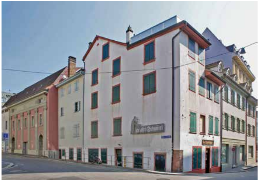
Das Haus zum Waldshut an der Ecke Untere Rheingasse/Sänergässlein. Zustand vor dem Umbau. Die seit dem Mittelalter angrenzende Hofbebauung am Sänergässlein wurde um 1910 durch einen Kinosaal (rot) mit neuer, vorspringender Gebäudeflucht ersetzt.
