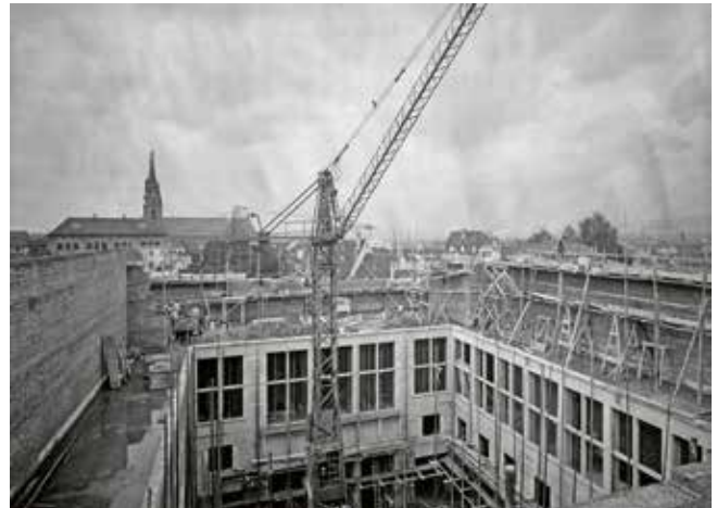
Blick über den grossen Hof, im Hintergrund das Münster. Im Gegensatz zu den Naturstein-Fassaden der Hauptgeschosse - mit Rudolf Christ «eine solide und für alle Zeit nobel und echt wirkende Haut» - wurde das zurückversetzte Dachgeschoss in Backstein aufgemauert und verputzt.
