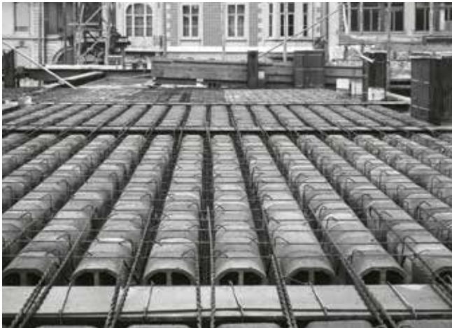
Deckenkonstruktion mit Eisenträgern, Hohlkörpern und Armierung vor dem Betonieren. Zu erkennen sind auch die aufsteigenden Schächte der «Heizungs- und Luftkonditionierungsanlage». Im Hintergrund die Häuser an der Dufourstrasse.
