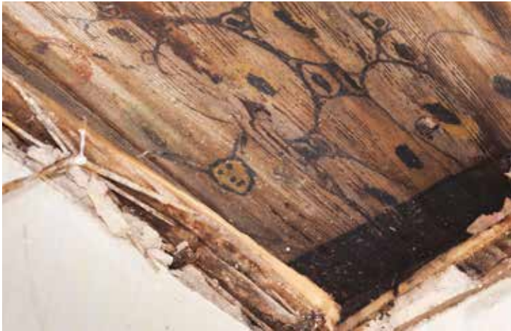
Bemalte Decke im 2. Obergeschoss des Schwarzen Bären: Mehrfarbige Marmorierung mit Tierköpfen (17. Jahrhundert), geschützt durch eine jüngere, abgehängte Putzdecke (19. Jahrhundert). Unten: Der Schwarze Bären 1967.
