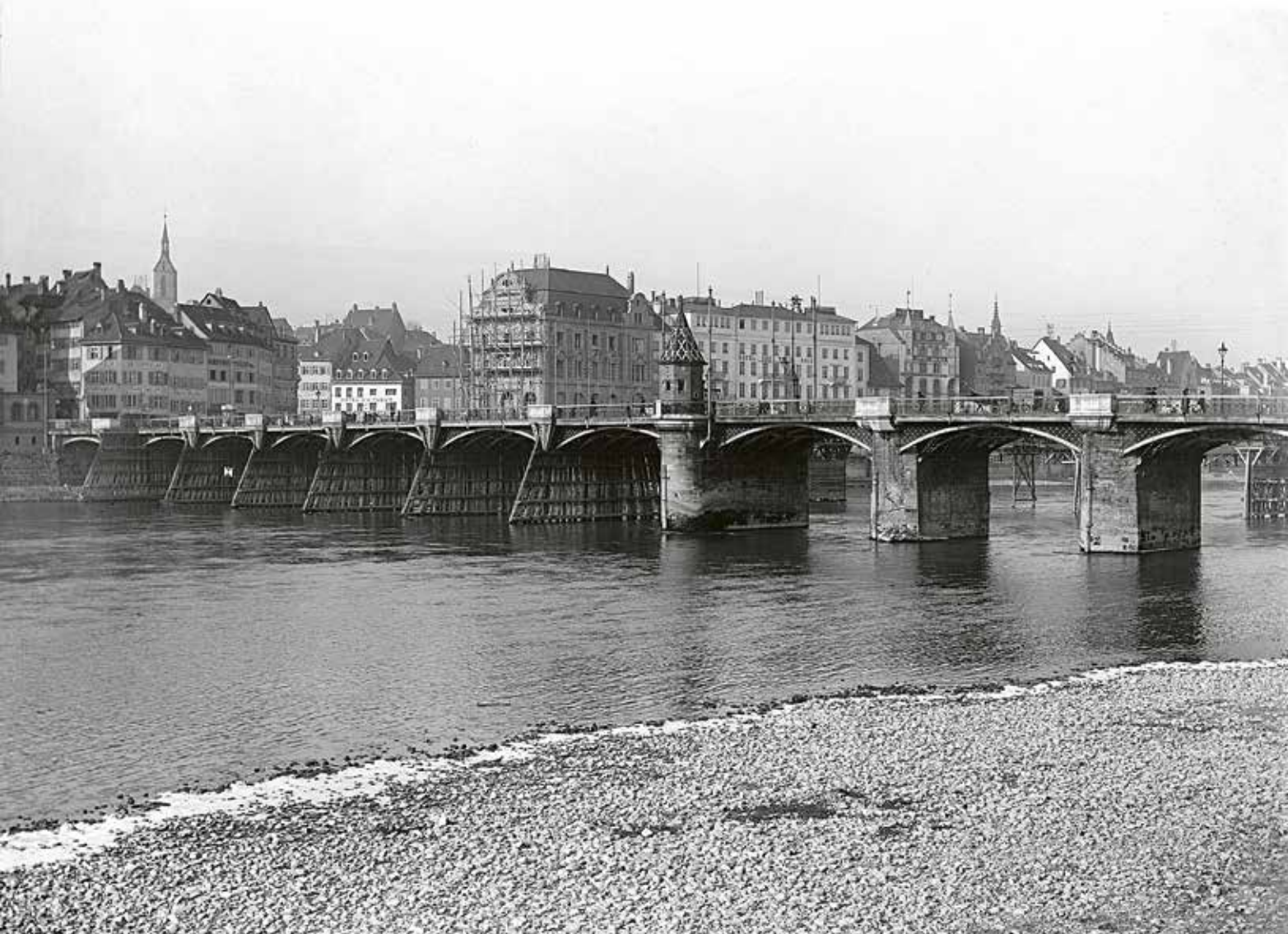
Die alte Rheinbrücke kurz vor dem Abbruch. Durch die Bögen sind die Pfeiler der provisorischen Brücke zu erkennen, die während der Errichtung der neuen Mittleren Brücke bestand. Ebenfalls zu sehen ist der noch teilweise eingerüstete Neubau der Kantonbank, heute Teil des Grandhotel Les Trois Rois. Foto 1903.
