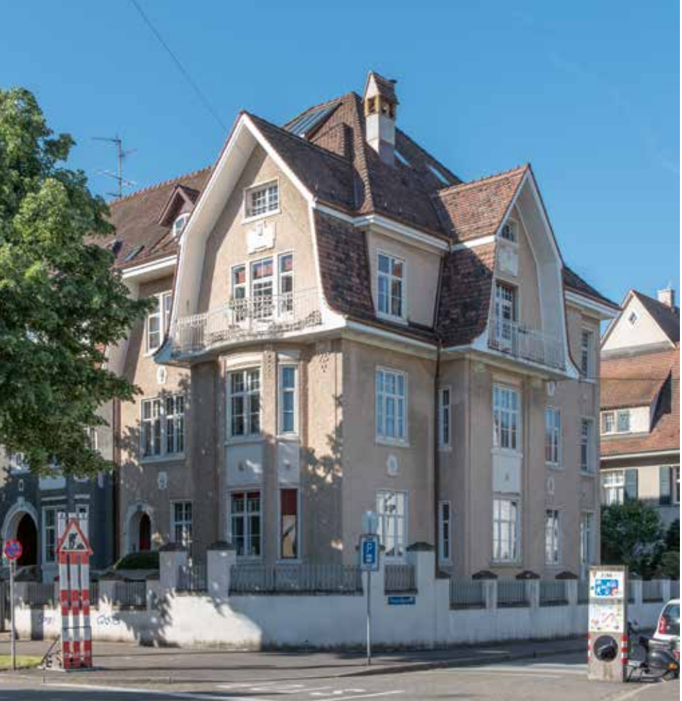
Das Haus nach Abschluss der Dachrenovation. Aus dieser Perspektive kommt die markante Dachform besondere gut zur Geltung.
