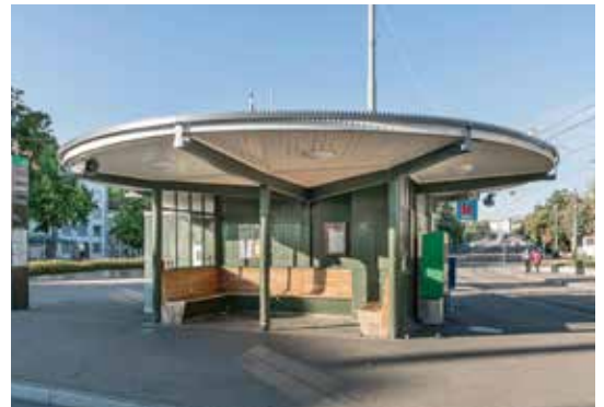
Warten unterm Vordach → S. 68
