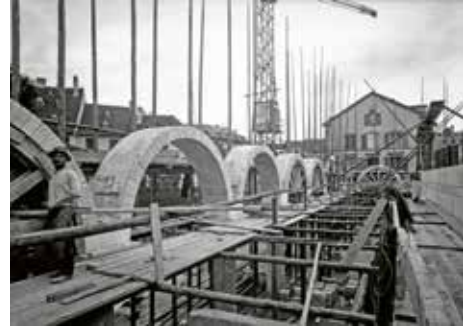
Baustelle im Bild → S. 88
