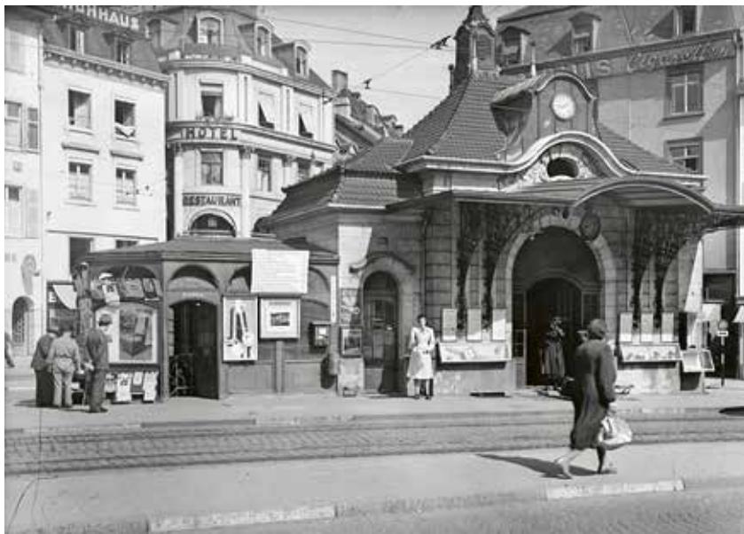
Erstes Stationsgebäude auf dem Barfüsserplatz, 1900 von Emil Faesch und Friedrich Werz errichtet. Das schicke Gebäude wurde 1946 abgerissen und durch einen Neubau ersetzt, der wiederum 1993 einer modernen Anlage weichen musste.
