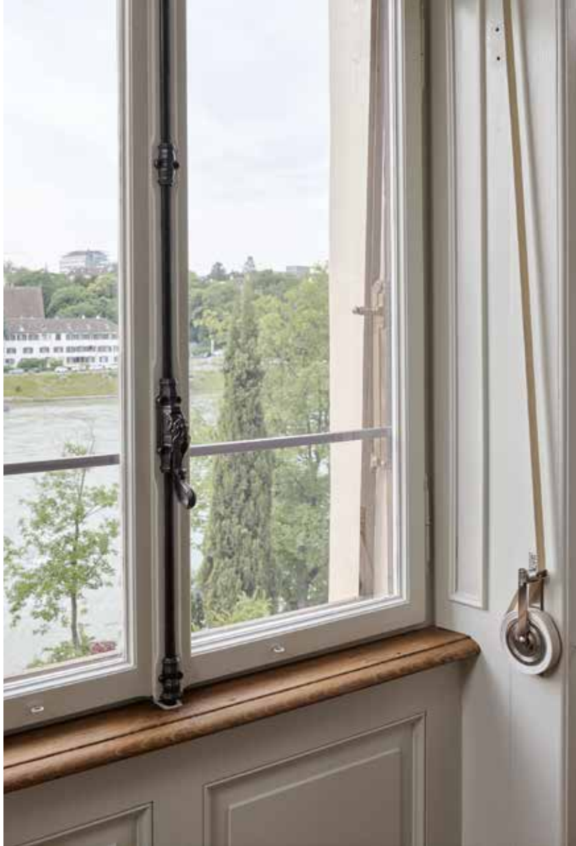
Blick auf den Rhein durch ein restauriertes Fenster aus der Bauzeit samt originalen Beschlägen.
