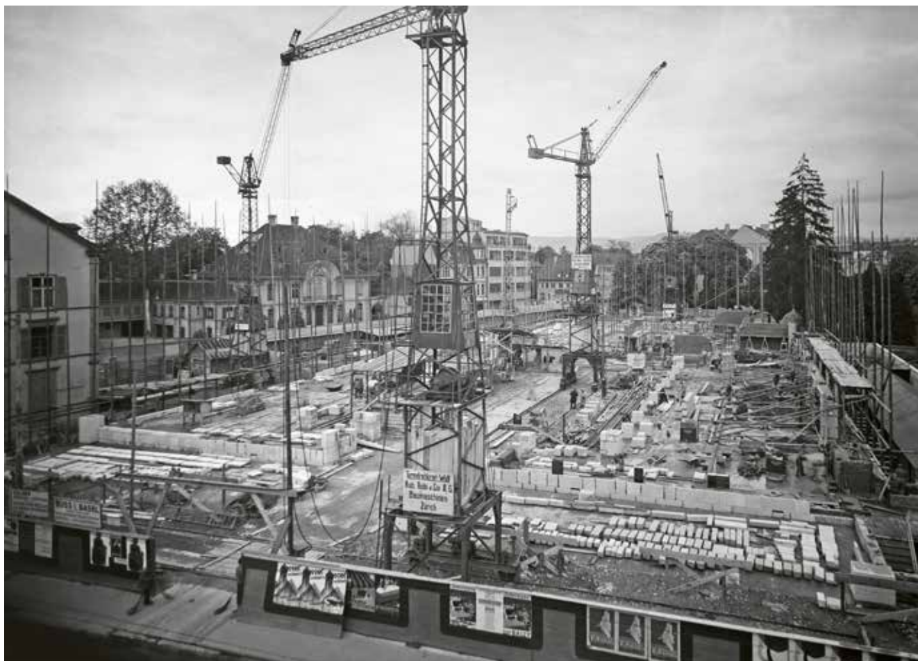
Grossbaustelle Kunstmuseum. Blick gegen den Aeschenplatz, links die Dufourstrasse. Sorgfältig bereitgelegt sind die Natursteine für das Aufmauern der mit Backstein hintermauerten Fassaden. Verwendet wurden beim Kunstmuseum zahlreiche Kalksteinsorten aus Solothurn, Laufen und Neuenburg sowie verschiedene Granitarten aus dem Tessin.
