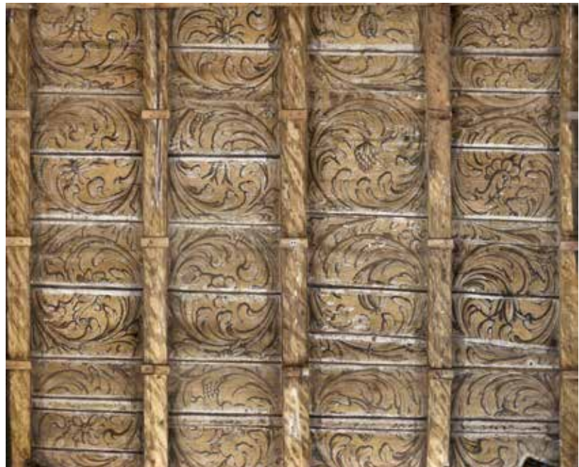
St. Alban-Vorstadt 50. Gesamtansicht der bemalten Balkendecke im 2. Obergeschoss. Fotogrammetrisches 3D-Modell.
