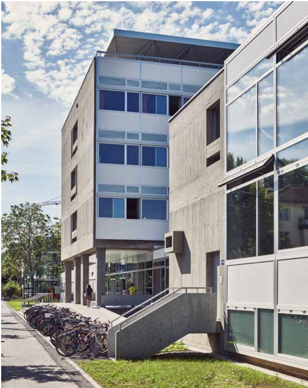
Die Hauptseite der Fachmaturitätsschule gegen die Engelgasse nach der Gesamtsanierung. Im Vordergrund die Turnhalle mit Eingang zur ehemaligen Hauswartung, dahinter der Klassentrakt mit dem Haupteingang. Die barrierefreie Zugänglichkeit wurde mittels einer parallel zur Strasse verlaufenden Rampe gelöst.
