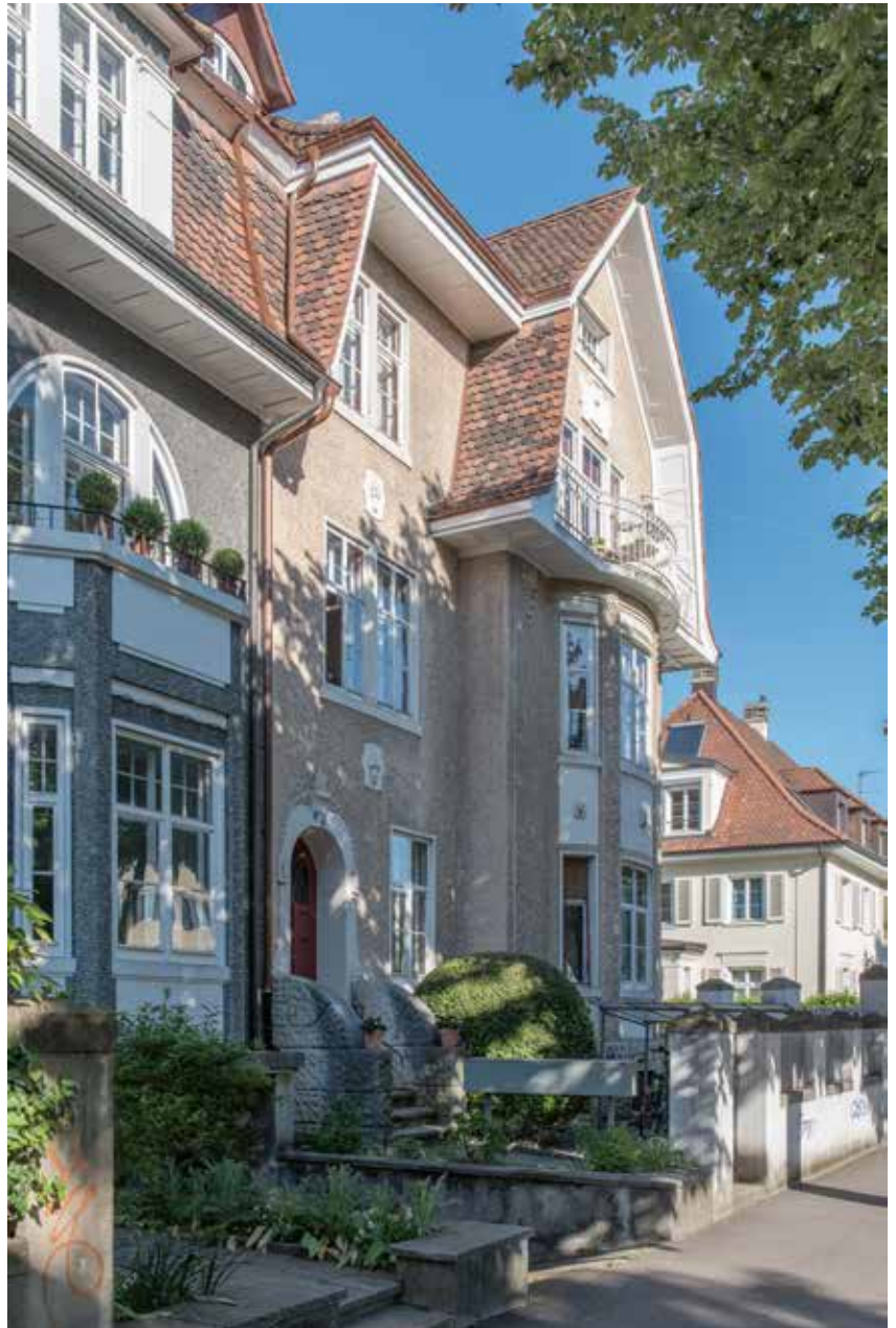
Das 1910 errichtete Eckhaus Laupenring 147/Realpstrasse bildet den Abschluss einer Mehrfamilienhausreihe, die der Architekt Heinrich Flügel als gestalterische Einheit geplant und ausgeführt hat. Die vier Häuser sind charakteristische Vertreter der Reformarchitektur.
