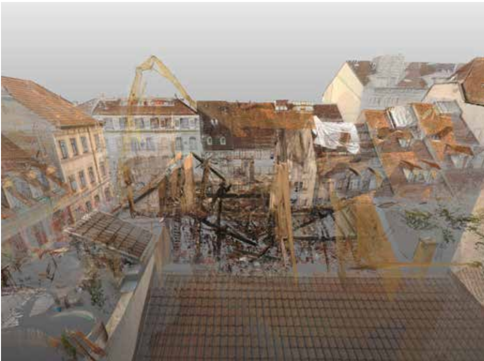
Blick vom Haus Utengasse 16 auf den Schwarzen Bären während der Notsicherung: Fotografie und Laserscan. In der Bildmitte die ausgebrannten Dachwerke der mittelalterlichen Hinterhäuser, die vor dem Teilabbruch gescannt wurden (im Vordergrund links das Laserscangerät).
