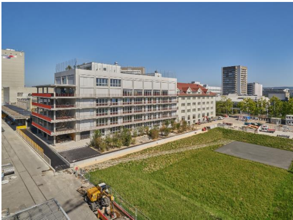
Abb. 3: Primarschule Lysbüchel (Baufeld 5)
