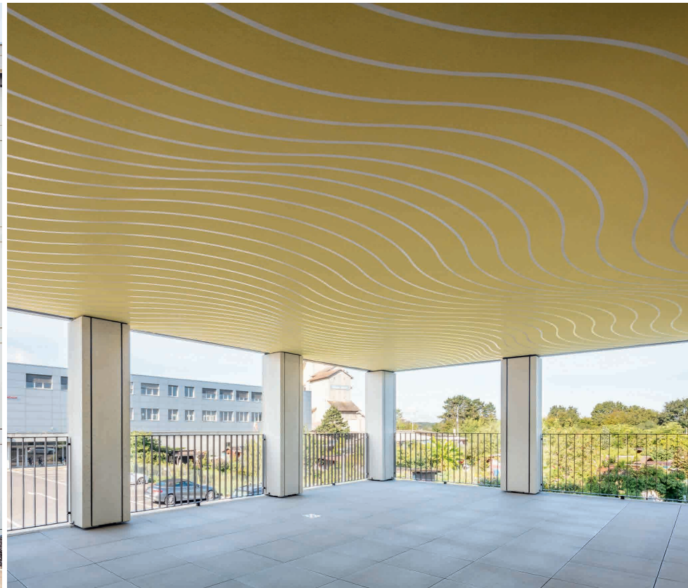
Decke Loggia (Kunst und Bau: Jürg Stäubli, Basel)
