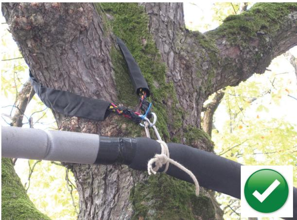
**Richtig:** Kabel und Wasserleitung fachgerecht mit Baumschlingen verlegt.
