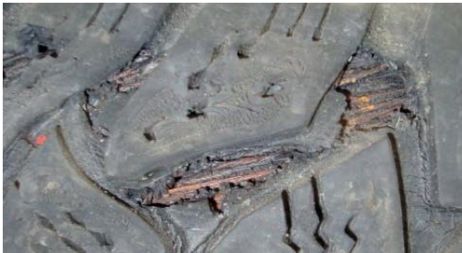
Stahlgürtel und Abdecklage sichtbar.
