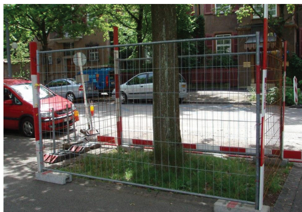
Abb. 101.01a Baumschutz auf Baustellen
