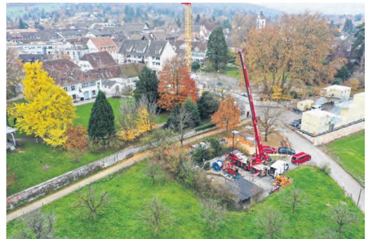
Luftbild zu Beginn der Arbeiten zur Einsetzung der neuen Förderpumpe und der Steigrohre beim Wasserentnahmeloach am Bachtelenweg.
