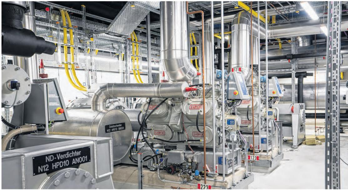
Wärmepumpen in der Zentrale der Wärmeverbund Lehenmatt Birs AG.
