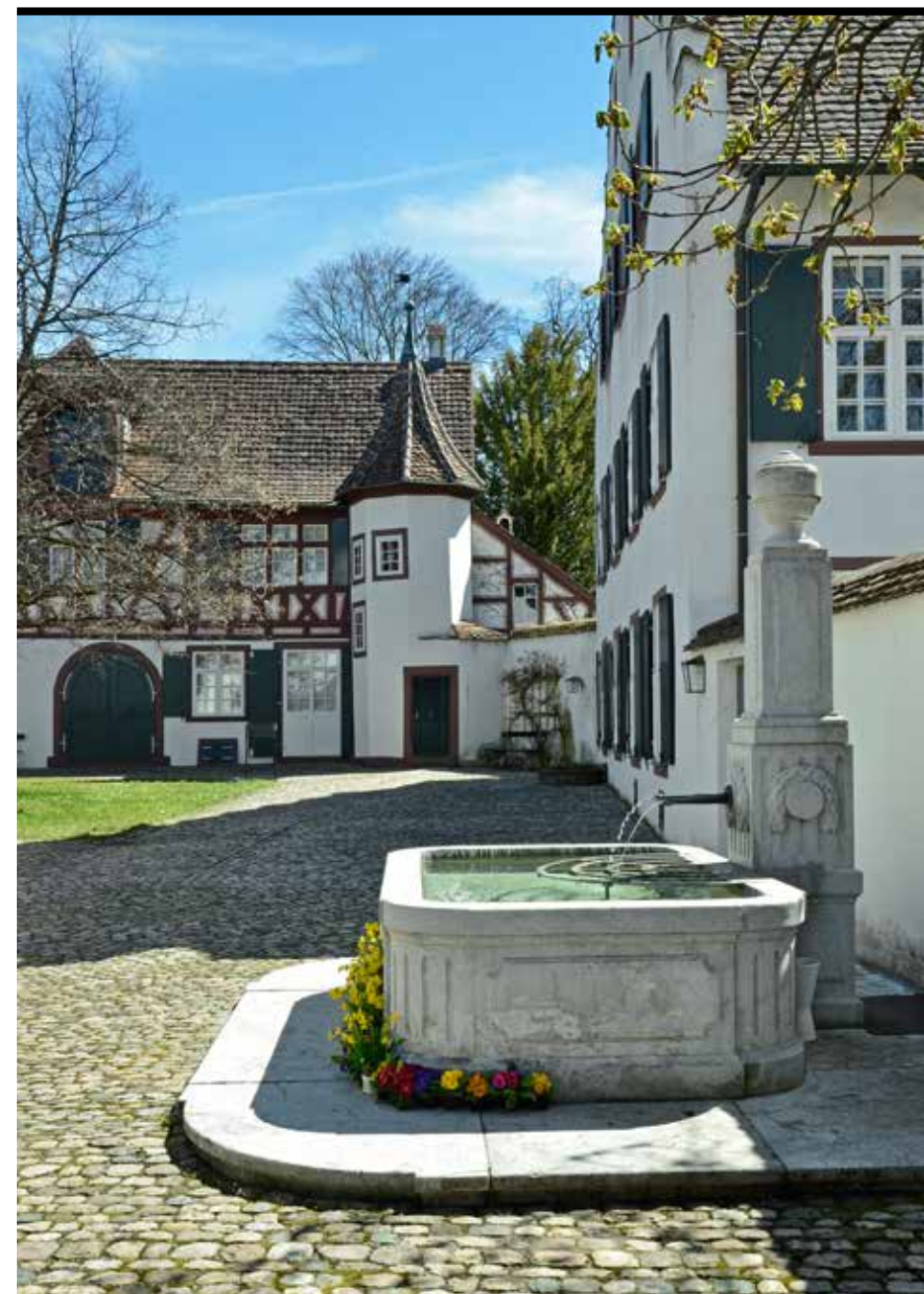
Blick in den Hof des Alten Wettsteinhauses mit dem Hinterhaus links und dem Neuen Wettsteinhaus rechts. | Fotos: Klaus Spechtenhauser, Flavio Karrer
