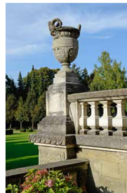
Balustrade aus Sandstein samt Eckpfosten mit Ziervase als Abschluss der gartenseitigen Terrasse des Neuen Wenken.
