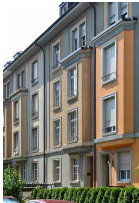
Beim Baumgartnerhaus von 1929 an der Edisonstrasse 9 im Basler Gundeldinger Quartier konnten mit einfachen und gezielten Massnahmen 58 % des Energieverbrauchs eingespart werden, ohne dass historische Bausubstanz geopfert werden musste: Innendämmung von Fassaden und Dach, Sanierung der Fenster, Montage einer Solaranlage.
