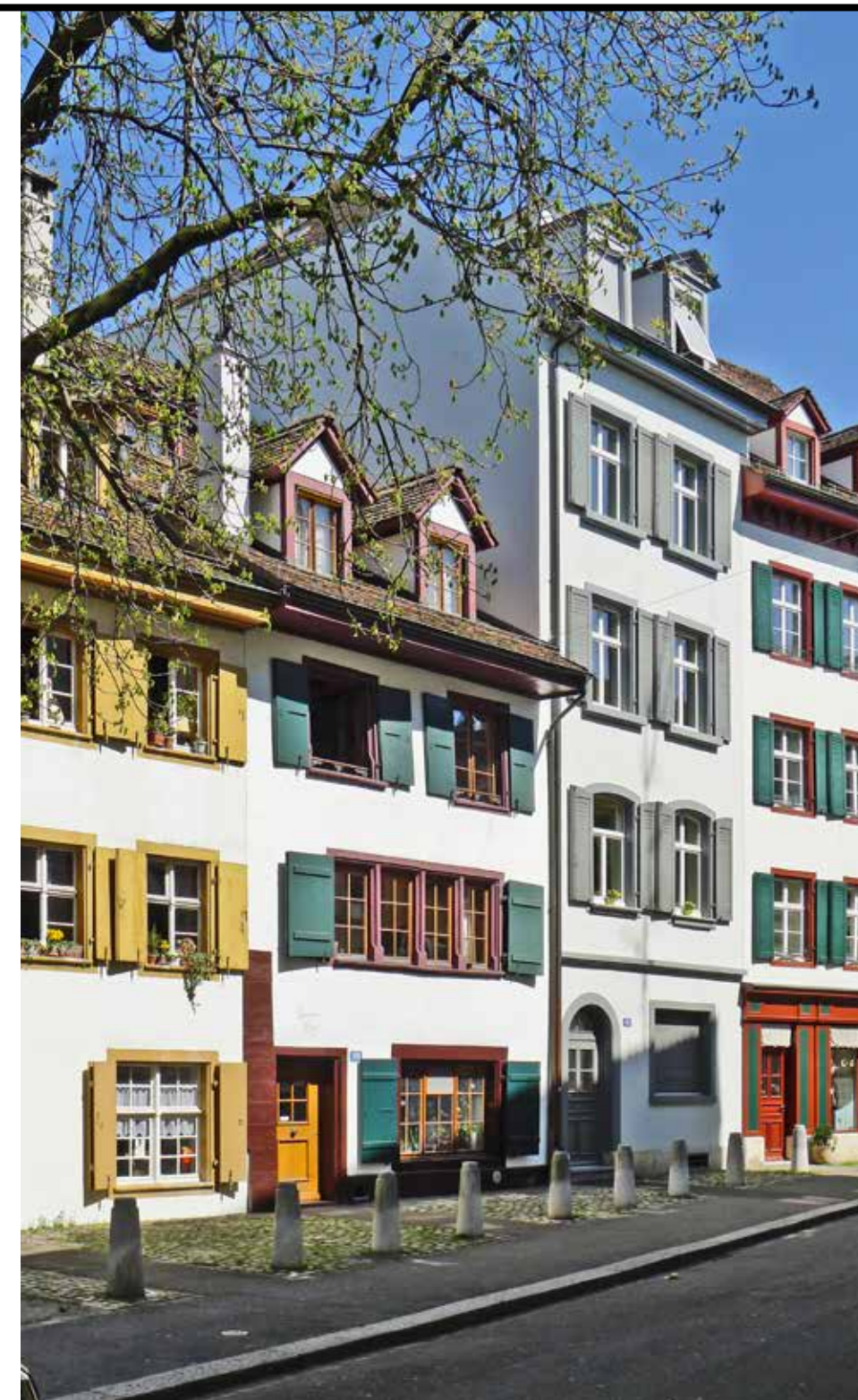
Die Bauweise und die Anlage von Altstadtshäusern – hier in der Rheingasse im Kleinbasel – beinhalten viele positive Faktoren, die zu einem geringen Energieverbrauch beitragen: Meist sind sie dicht aneinander gebaut, verfügen über dicke, wärmespeichernde Mauern, haben schmale Fassaden und damit geringe Aussenflächen, öffnen sich nur mit kleinen Fenstern gegen aussen.
