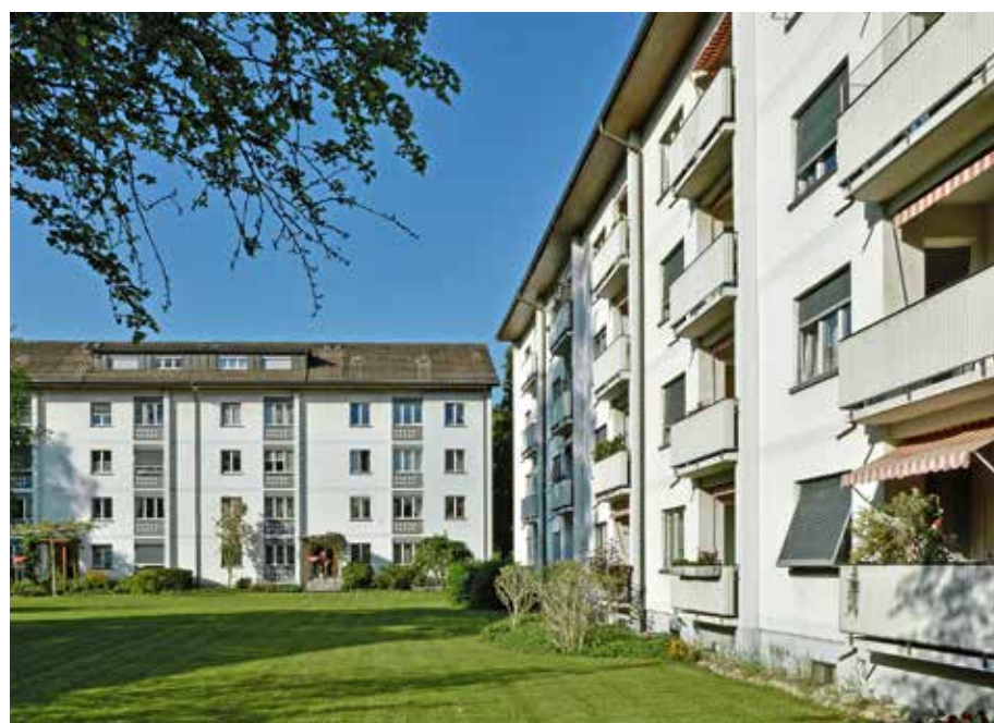
Bei der 1952-1954 errichteten Siedlung «Zum Blauen» zwischen Bernerring und Kastelstrasse in Basel wurden verschiedene Szenarien für eine nachhaltige Entwicklung geprüft. Es hat sich herausgestellt, dass die Variante der Erhaltung und Instandsetzung die beste Strategie ist, um die Siedlung 2000-Watt-tauglich zu machen.
