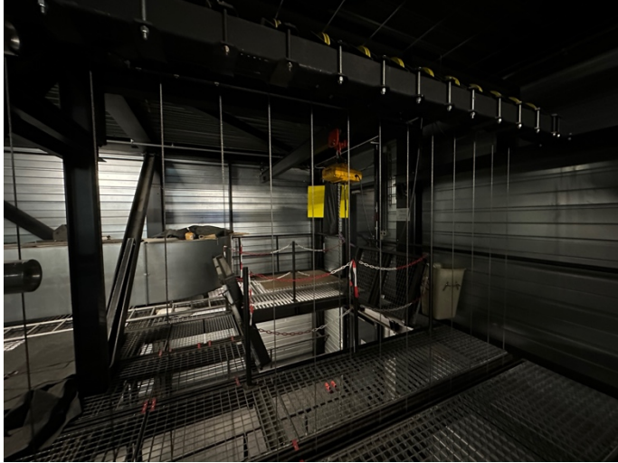
Einbringöffnung im Schnürboden
