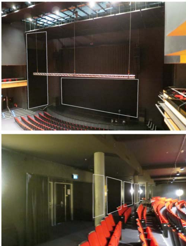
Abbildung 9 - Lage der «improvisierten» Akustikmassnahmen (weiss umrandete Bereiche) seitlich des Bühnenportals, an der Saalrückwand, sowie direkt an der Vorderseite des Eisernen-Vorhangs.
