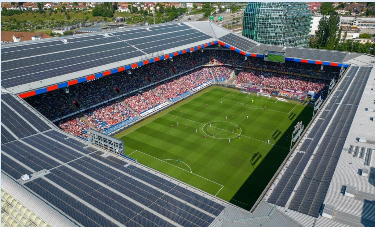
Le toit du Joggeli est équipé d'une installation photovoltaïque. ©FC Basel 1893
