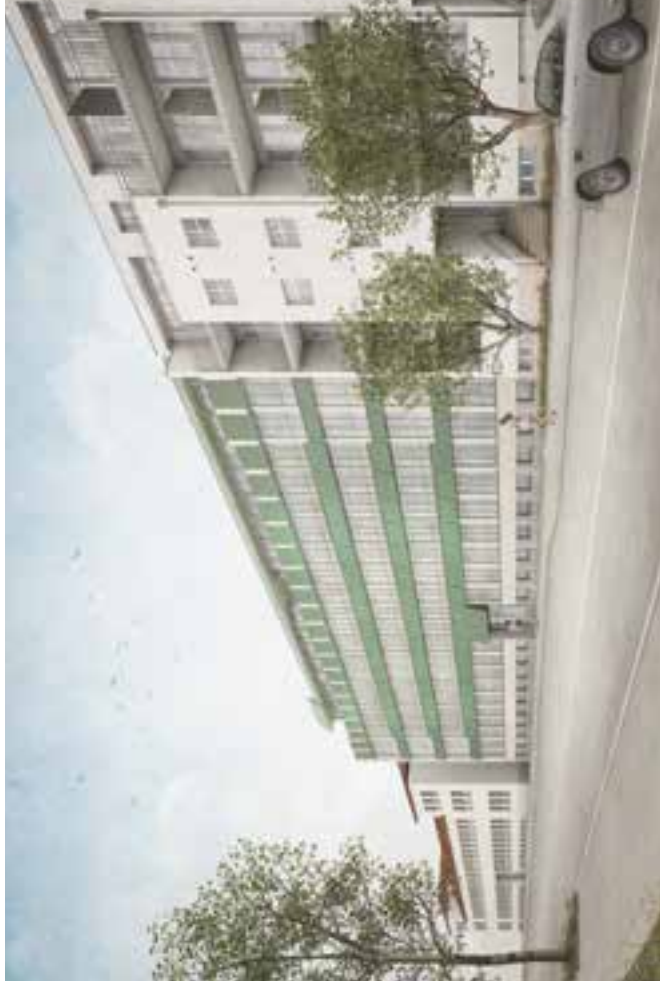
Die horizontale Bandfassade aus grünen Photovoltaikpaneelen, entspricht im Ausdruck der Stützen-Plattenstruktur des Bestandes und tritt in einen Bezug zu Stimmungen der industriellen maritimen Rheinholenslandschaft.
