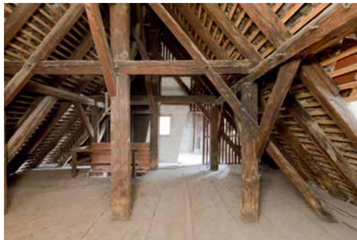
Dachwerk von 1364 über dem nördlichen Teil des Kohlerhofs (Petersgraben 5). Firstständer und stehender Stuhl im 2. Dachgeschoss.
