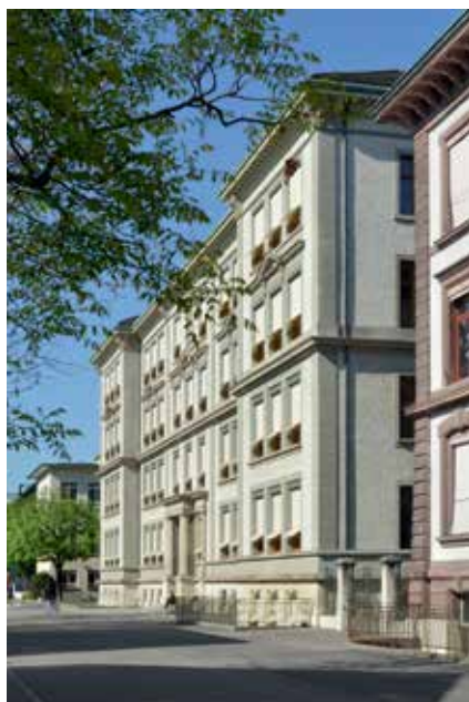
Die Hauptfassade des Schulhauses gegen Südosten. Charakteristisch für den monumentalen Bau im Stil der Neurenaissance ist die grosszügige Befensterung, was den damaligen Forderungen der Hygienebewegung nach Licht und Luft entgegen kam. - Unten: Auch die Korridore und die Treppenhäuser an den Stirnseiten sind grosszügig belichtet.
