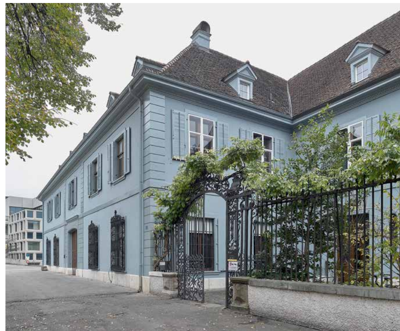
Der Bockstecherhof in der wiederhergestellten monochromen Farbfassung von 1844. Das Graublau wurde gegenüber dem Befund leicht aufgehellt.
