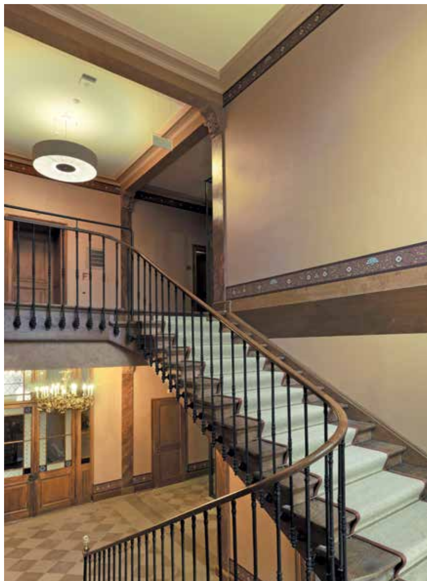
Die Wandflächen des Treppenhauses sind heute wieder von marmorierten Friesen und einer Bordüre mit Blumendekor gerahmt.
