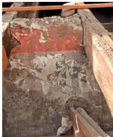
Hofseitige Fassade des Kohlerhofs mit Bemalung der Traufe: zunächst schwarzer Bollenfries mit Blumenzier (15. Jahrhundert), später breites, rotes Band, seit dem 18. Jahrhundert verdeckt durch eine hölzerne Verkleidung (Dachhimmel).
