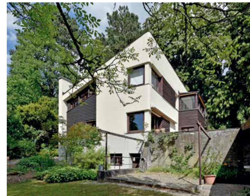
Das Haus Sandreuter heute. Ansicht von Westen. Charakteristisch für die Schmalseite ist der eingezogene, Holzverschalte Bereich vor Treppenhaus und Küche. Gut zu erkennen sind die Schiebefenster mit in Stülpchalung ausgeführten Schiebeläden.
