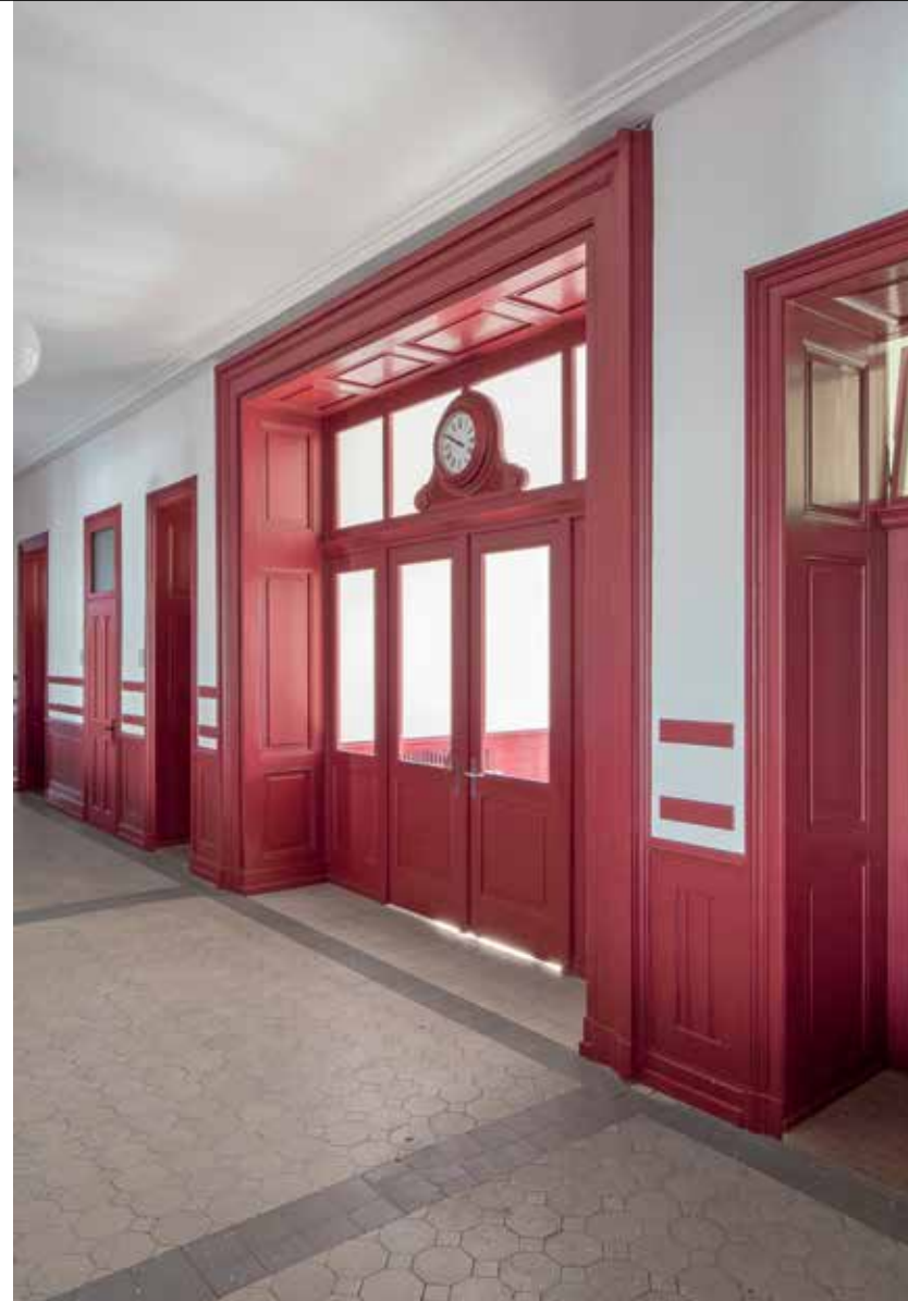
Der breite Erschliessungskorridor mit zentralem Haupteingang. Bei der Sanierung der Oberflächen wurde der Geist des Bestands gewahrt. Die Farbwahl für das Holzwerk basiert auf der rotbraunen Fassung der 1930er Jahre.
