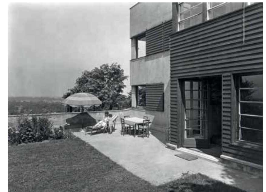
Rudolf Steiger, Flora Steiger-Crawford, Haus Sandreuter, Riehen, 1924. Wohnzimmer mit Veranda gegen den Garten; Gartenseite mit Sitzplatz. Gut zu erkennen die überbeck angelegten Schiebefenster mit Schiebeläden.
