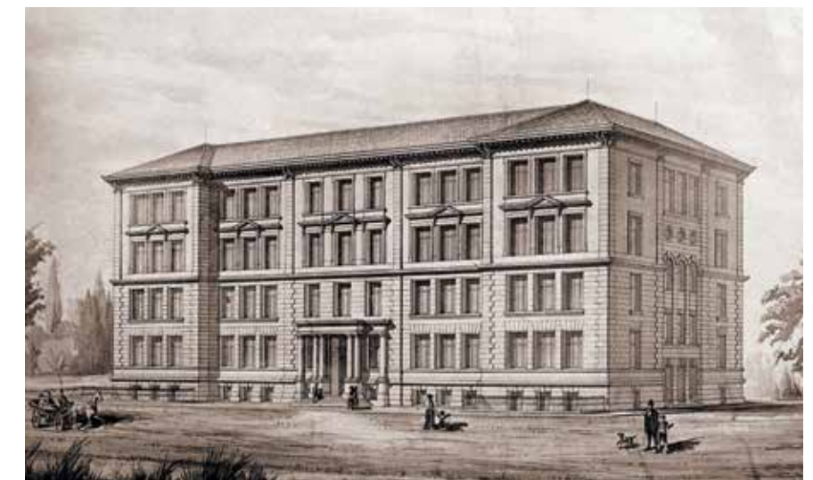
Das Schulhaus St. Johann stand 1888 als «Schulpalast» im Stil der Neurenaissance allein auf grüner Wiese. Das flachgeneigte, zurückhaltend gestaltete Walmdach vermittelt den Eindruck eines Flachdachbaus. Die Fassade ist im Rhythmus von jeweils drei zusammengezogenen Fensterachsen gegliedert und bestimmt die Wirkung des Schulhauses.
