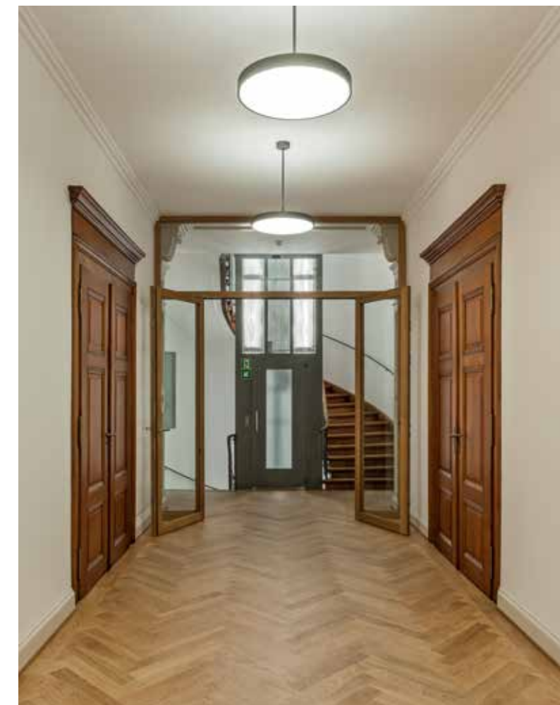
Blick durch den grosszügigen Mittelkorridor im Obergeschoss zum Treppenhaus mit neuem verglastem Brandabschluss und Lift (strassenseitige Raumschicht rechts). Unten: Die repräsentativen Haupträume haben den Charakter grossbürgerlicher Wohninterieurs aus dem 19. Jahrhundert bewahrt.
