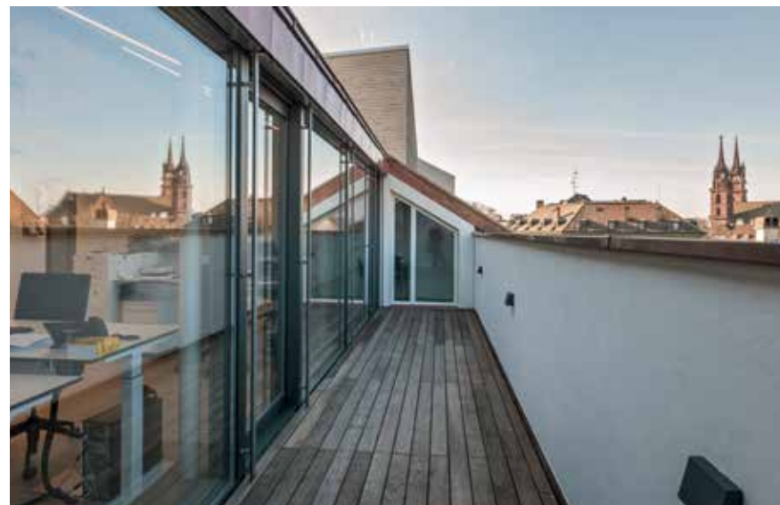
Die 1964 hinter den Traufen eingebauten Dachterrassen ermöglichen eine grosszügige Belichtung des Innenraums.
