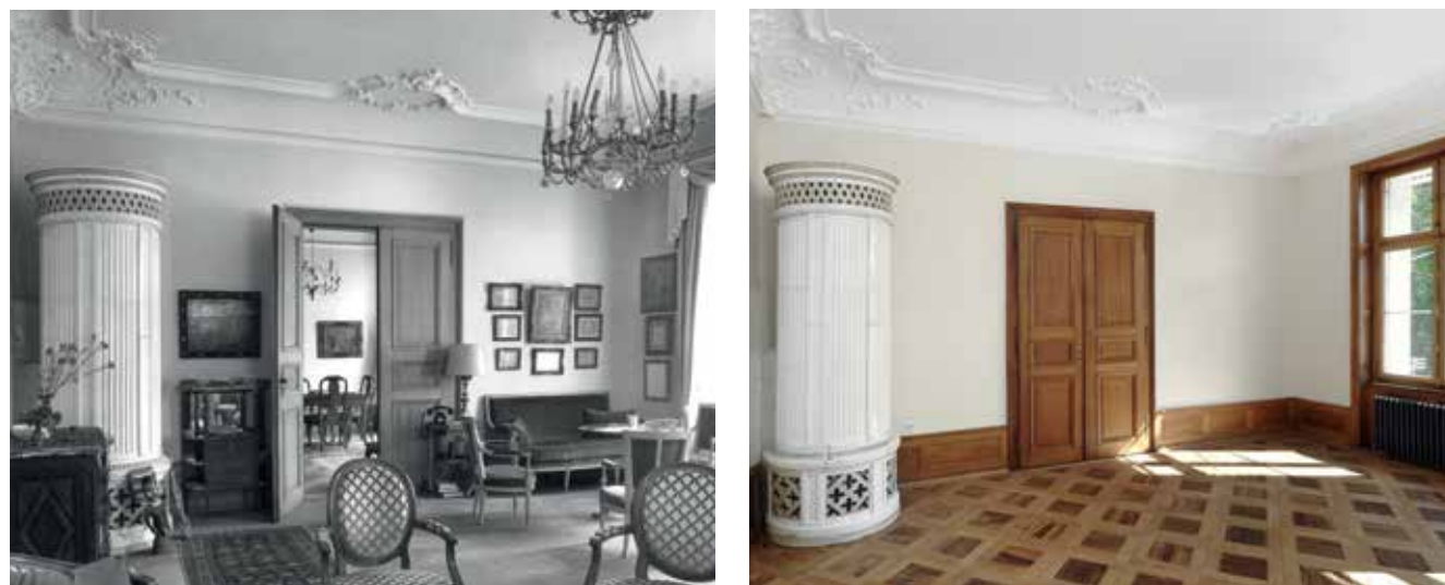
Die originalen Ausstattungselemente des Salons – edles Tafelparkett, weisser Kachelofen, eichene Lambris, Türen und Fenster sowie Stuckdecke – wurden wieder zur Geltung gebracht. Aufnahmen von 1973 und 2017. – Unten: Grundriss des Obergeschosses mit strassenseitiger Raumfolge: Salon, Wohnzimmer und Schlafzimmer (v.l.n.r.). Originalplan von Johann Jakob Stehlin d.J., 1860.
