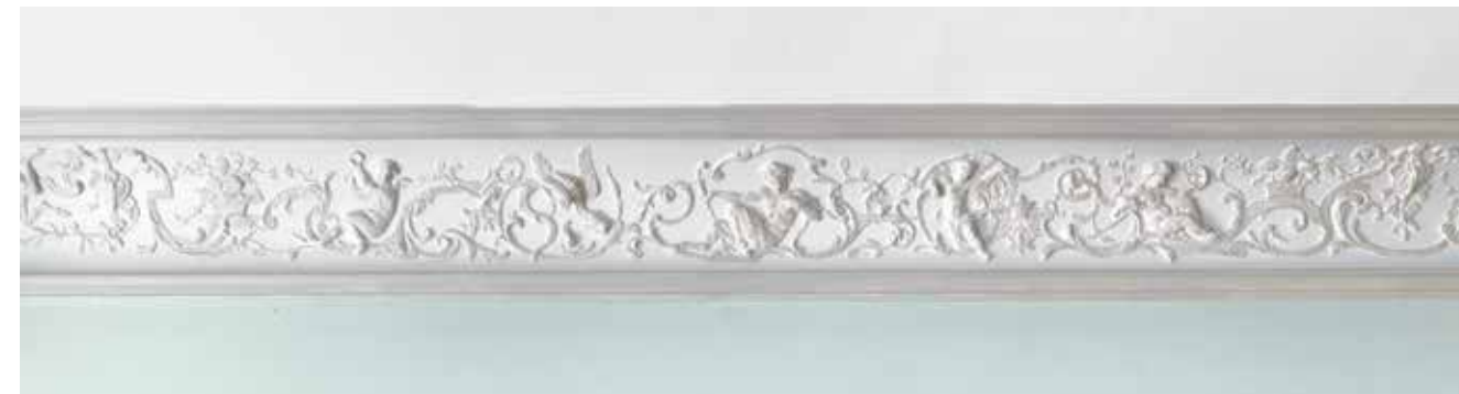
Stuckfries mit Ranken und Putti in der Deckenkehle des strassenseitigen Eckzimmers im Erdgeschoss.
