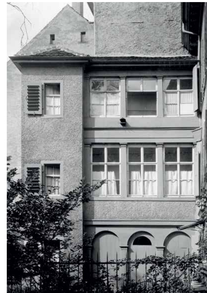
Klassizistischer Laubengang von 1829, der als Zugang zum Abort diente. Der gemauerte Latrinenturm links steht über der Abwasserdohle im einstigen Stadtgraben.
