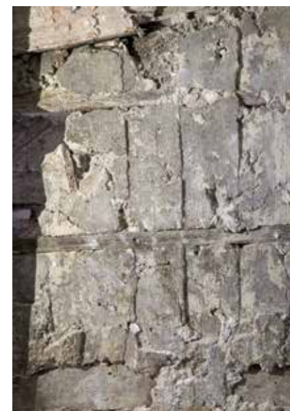
Abdrucke von Brettschindeln, die bei der Ausfachung des Trennwändchens zwischen den Häusern Nr. 44 und Nr. 46 als Schalungsbehelf verwendet wurden. Die Wand ist anhand von hier nicht sichtbaren Ständern dendrochronologisch ins Jahr 1342 datiert.
