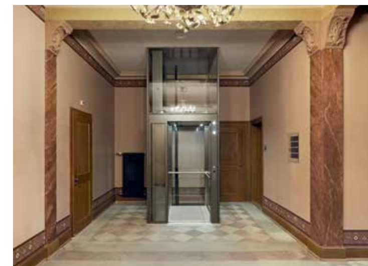
Nach Farbbefunden wurde die beige Zweitfassung im Vestibül und Haupttreppenhaus wiederhergestellt. Die hindernisfreie Erschliessung erforderte den Einbau eines Personenaufzugs, der nicht in der Achse der Haupteintrichtung, sondern an der Wand des Nebentreppehauses zu stehen kam.
