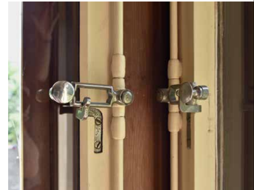
Details und Materialien im Haus Sandreuter. Raumbestimmendes, über Eck angelegtes Schiebefenster im Esszimmer (linke Seite); Holz und Linoleum als Bodenbeläge; originaler Schiebeladen mit Stülpschalung; aus der Bauzeit stammende Espagnolettenverschlüsse auf der Innenseite des Schiebefensters.
