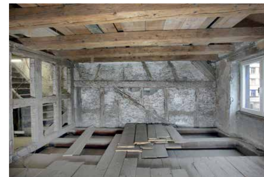
Die südliche Brandmauer im 2. Obergeschoss von Nr. 72 als Quelle der Baugeschichte: Der untere schräge Balken in der Wand ist Rest eines Dachs des Nachbarhauses Nr. 70 (16. Jahrhundert). Der horizontale Balken darüber und die schrägen Balken oben gehören zum ehemaligen Dachwerk des Hauses Nr. 72 (1626/27). Die Boden- und Deckenbalken im Vordergrund, die Riegelwand links und die Strassenfassade rechts stammen vom Umbau zum Wohnhaus 1802.
