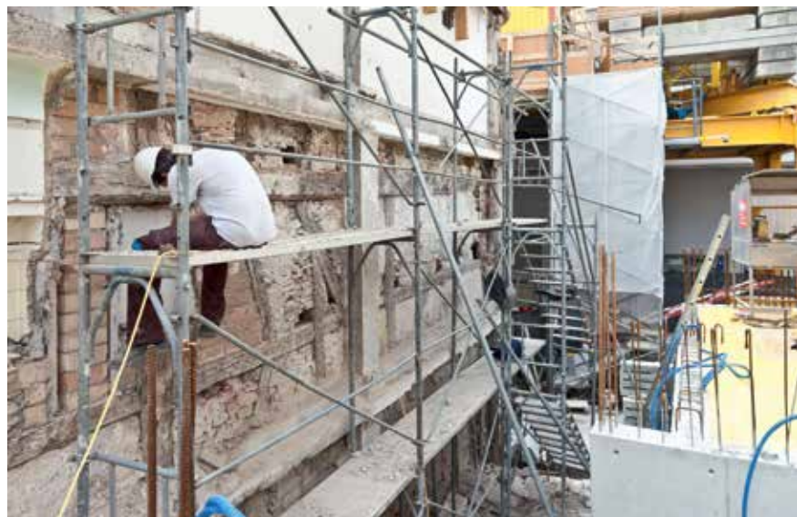
Ein Mitarbeiter der Bauforschung während der Untersuchung des freigelegten Fachwerks an der Brandmauer zwischen Rebgrasse 25 und 27.
