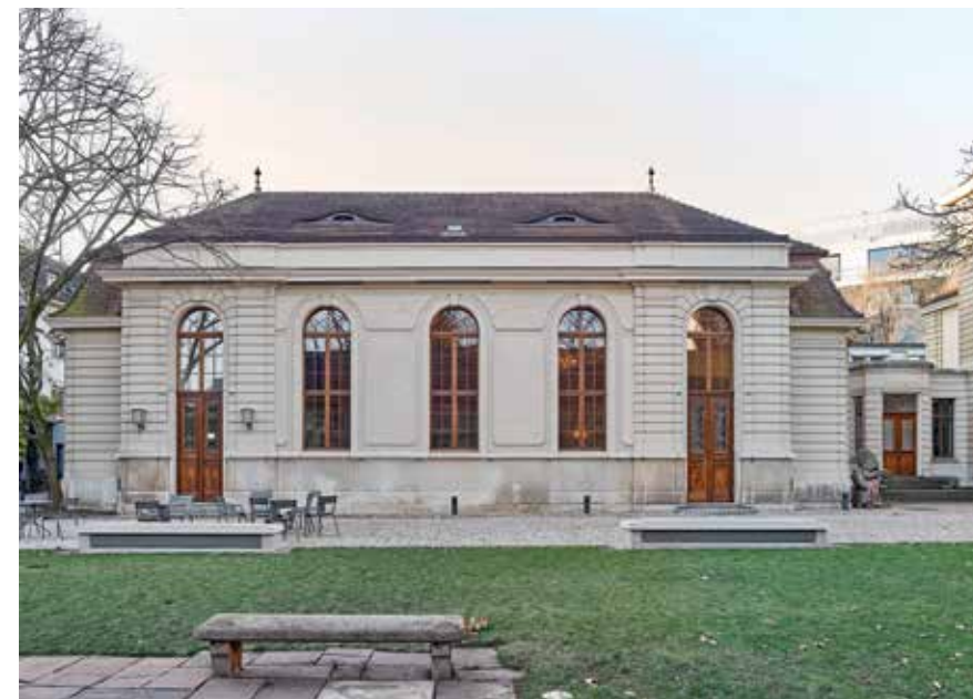
Der 1903 von Fritz Stehlin und Emanuel La Roche errichtete Musiksaal nach der Renovation. Für den nötigen Sonnenschutz sorgt eine im Dachgesims versteckte Senkrechtmarkise. Vor dem Gebäude sind die als steinerne Sitzbänke getarnten Zu- und Abluftöffnungen der neuen Lüftungsanlage zu erkennen.
