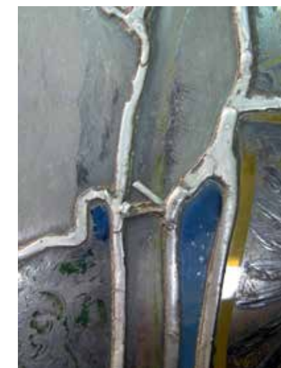
Oben: Detail der Standesscheibe Stift St. Gallen vor und nach der Reinigung. Dank der Entfernung des Schmutzes erscheinen die Bleiruten wieder schlanker und die einzelnen Gläser transparenter. Mitte: Standesscheibe Zug. Ein Glassprung vor und nach der Reparatur. Unten: Standesscheibe Luzern. Eine gebrochene Bleirute vor und nach der Reparatur.
