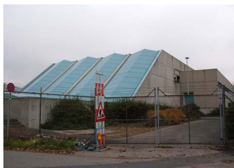
Zwischenpumpwerk der ARA Basel
