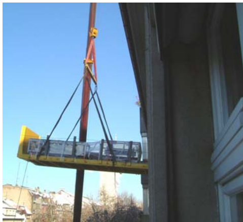
Hochsicherheitswerkbank während des Einbaus (links) und im betriebsfertigen Zustand im Biosicherheitslabor des KL BS (rechts)
