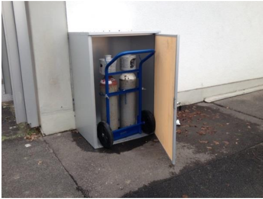
Bild 3 – Metall-Lagerschrank belüftet
